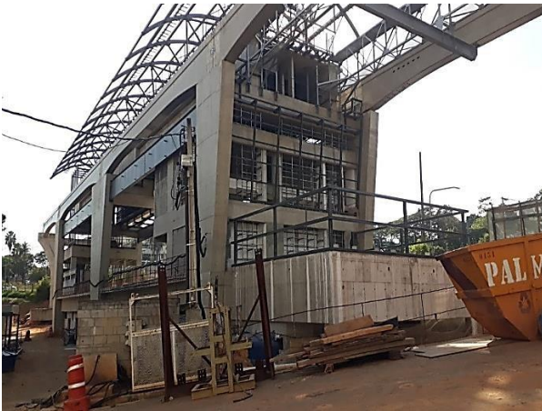
Corpo da Estação: obra bruta.
