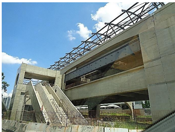
Corpo da Estação: obra bruta.
