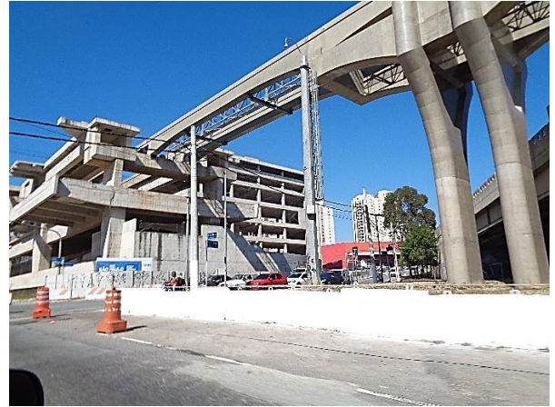
Corpo da Estação: obra bruta.
