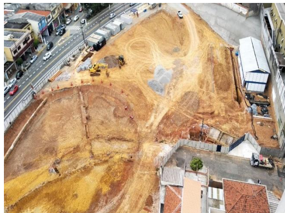
Estação Vila Formosa – raspagem do terreno e instalação do canteiro de obras.
