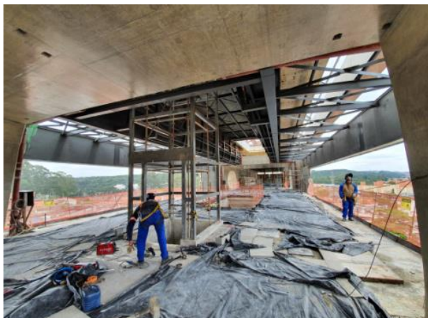
Obra Civil – colocação do piso no mezanino.
