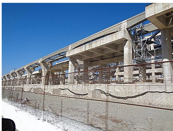
Setor 5 - Estrutura de concreto: obra bruta.
