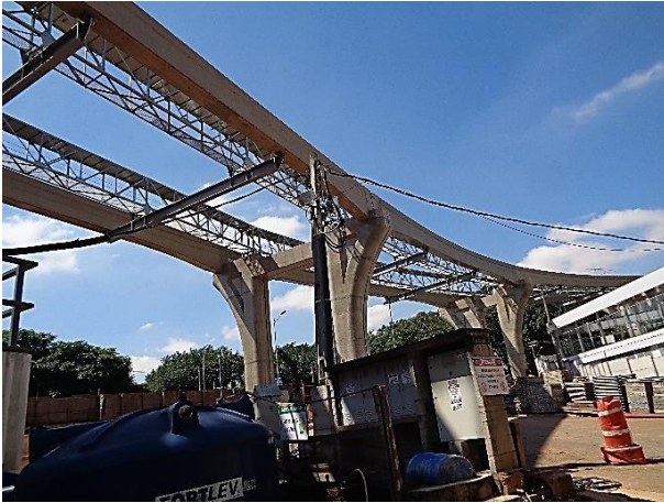
Vias do monotrilho: obra bruta.
