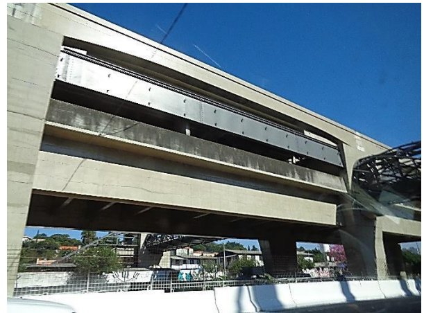
Corpo da Estação: obra bruta.
