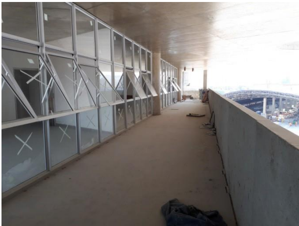
Salas Operacionais – execução do acabamento.
