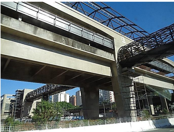
Corpo da Estação: obra bruta.
