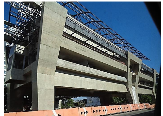
Corpo da Estação: obra bruta.
