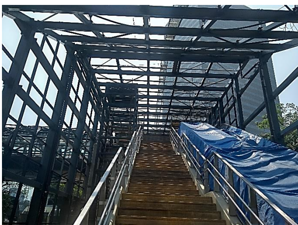
Montagem de estrutura metálica no acesso
