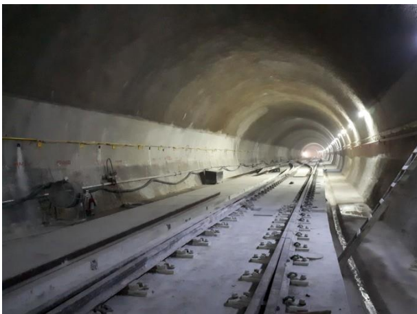
Túnel de Via 07 – em execução a instalação de trilhos e preparação para instalação da passarela de emergência.
