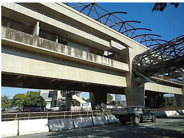
Corpo da estação: obra bruta.
