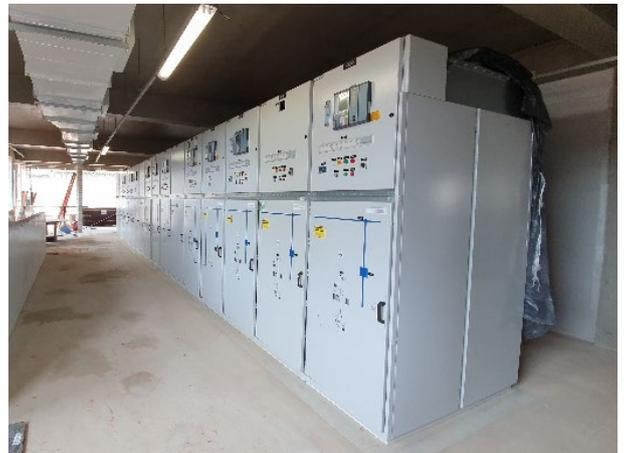
Obra Civil – execução do acabamento, montagem dos dutos de ventilação, infraestrutura de iluminação e tomadas e cubículos da Sala de
