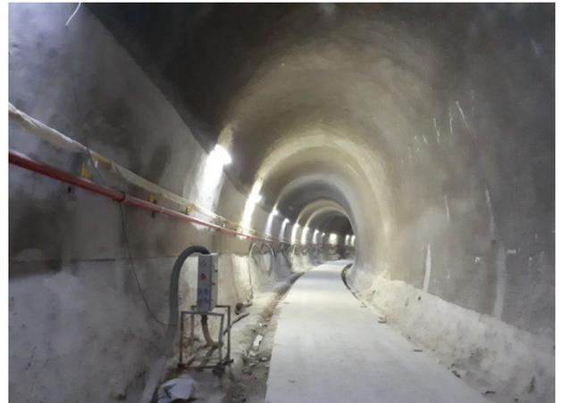
Túnel de Via 05 – executada a laje de regularização para as vias permanentes e em andamento a instalação da tubulação de incêndio.
