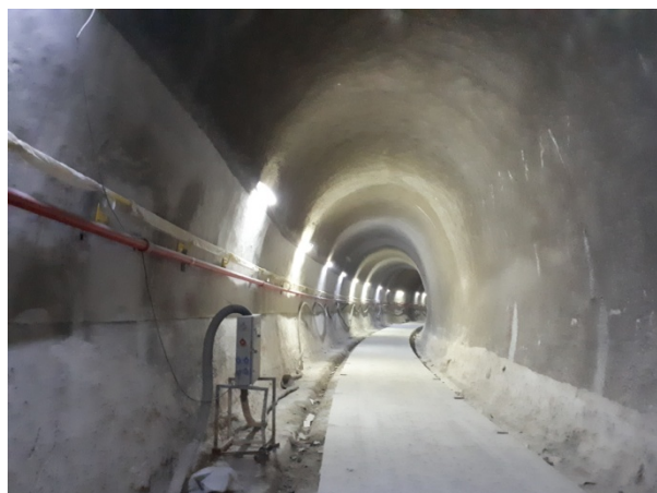
Túnel de Via 05 – executada a laje de regularização para as vias permanentes e em andamento a instalação da tubulação de incêndio.
