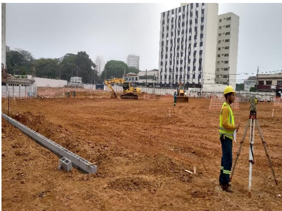
Estação Vila Formosa – Terraplanagem para acerto do terreno em andamento.
