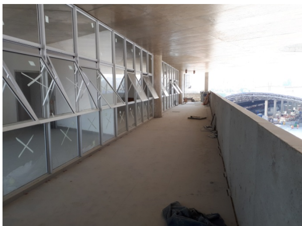
Salas Operacionais – execução do acabamento.
