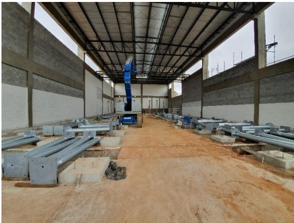
Obra Civil – execução da alvenaria, acabamento e base metálica dos equipamentos da Sala de Elétrica.
