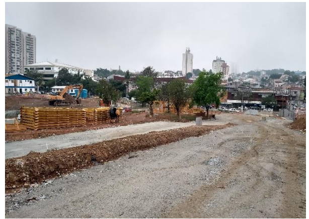
Estação Anália Franco – vista geral do canteiro.
