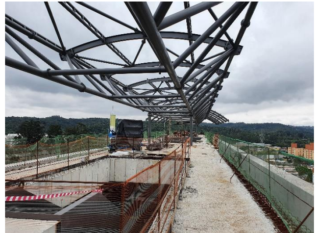
Obra Civil – concluído o lançamento dos módulos da cobertura metálica da estação.
