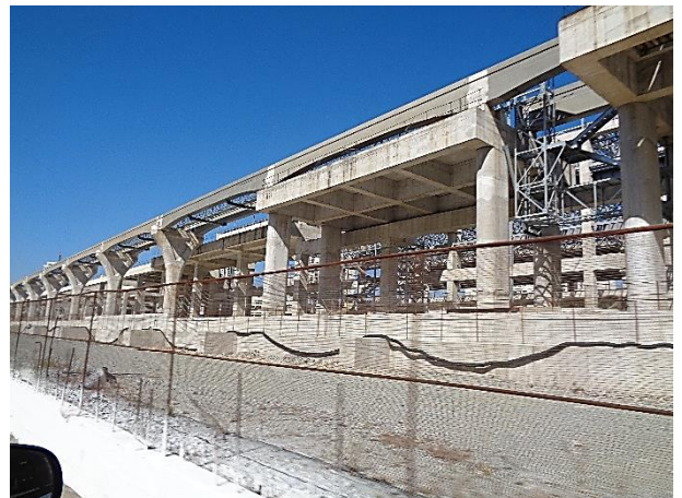
Setor 5 - Estrutura de concreto: obra bruta.
