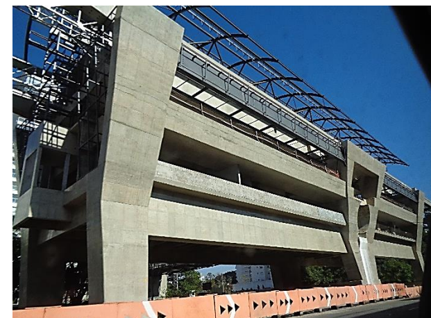
Corpo da Estação: obra bruta.
