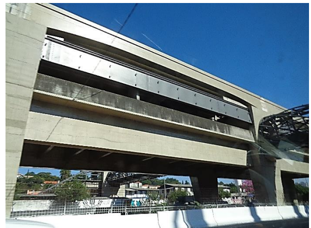
Corpo da Estação: obra bruta.
