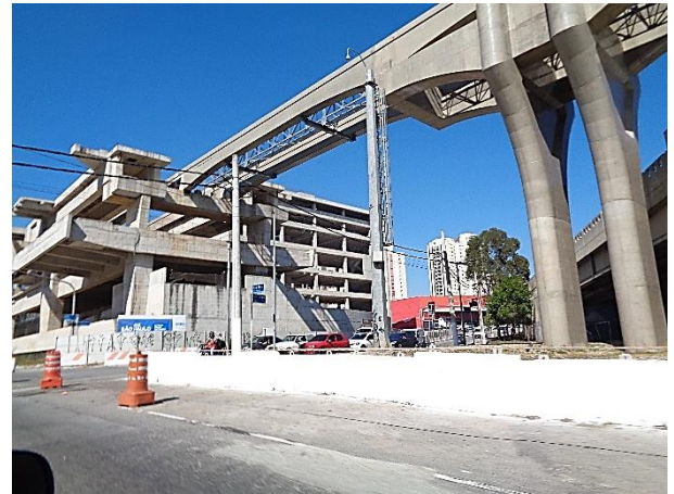
Corpo da Estação: obra bruta.
