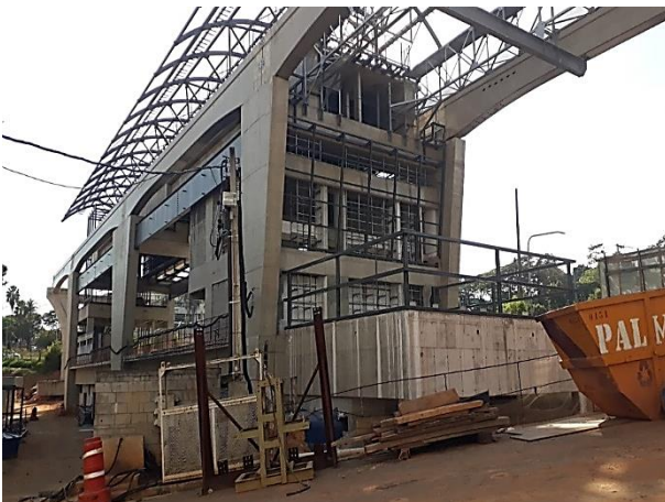
Corpo da Estação: obra bruta.
