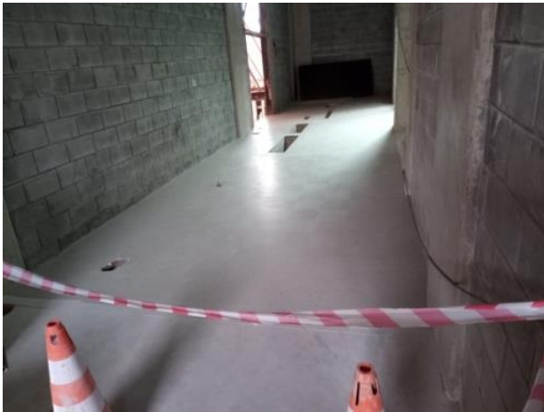
Obra Civil – instalação de paviflex no piso das Salas Técnicas 1.
