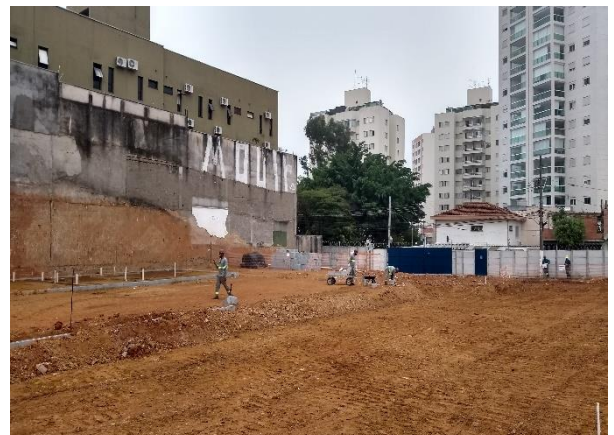
Estação Vila Formosa – Em andamento bases para execução das instalações do canteiro de obras.
