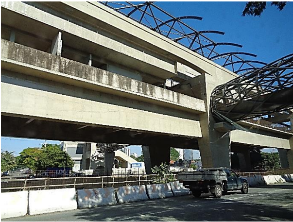
Corpo da estação: obra bruta.
