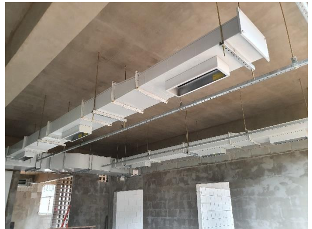
Obra Civil – execução do acabamento, montagem dos dutos de ventilação e infraestrutura de iluminação e tomadas da Sala de Controle.
