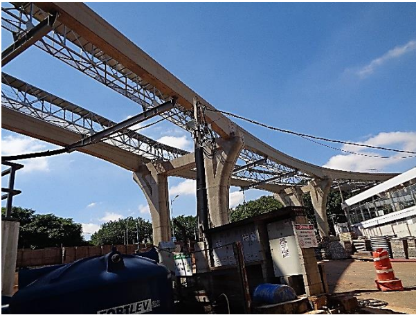
Vias do monotrilho: obra bruta.
