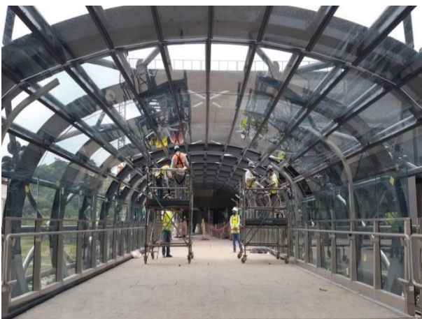
Instalação dos vidros na passarela.
