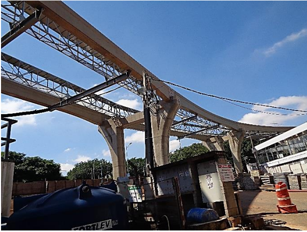
Vias do monotrilho: obra bruta.
