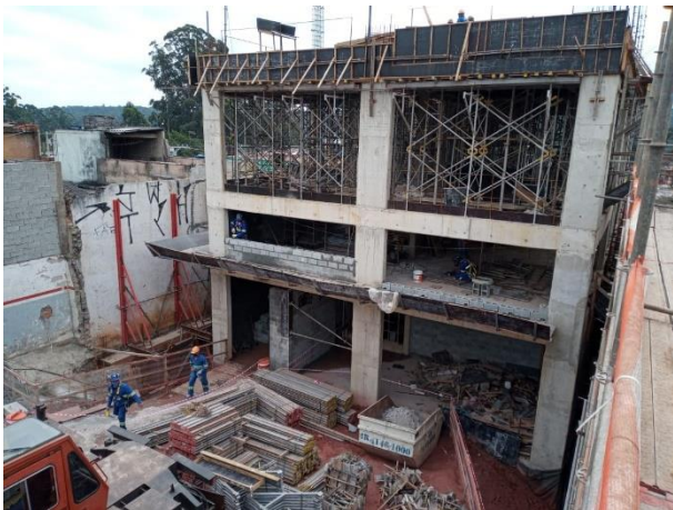
Obra Civil – Montagem de forma e armações da Laje de cobertura das Salas Técnicas 2.
