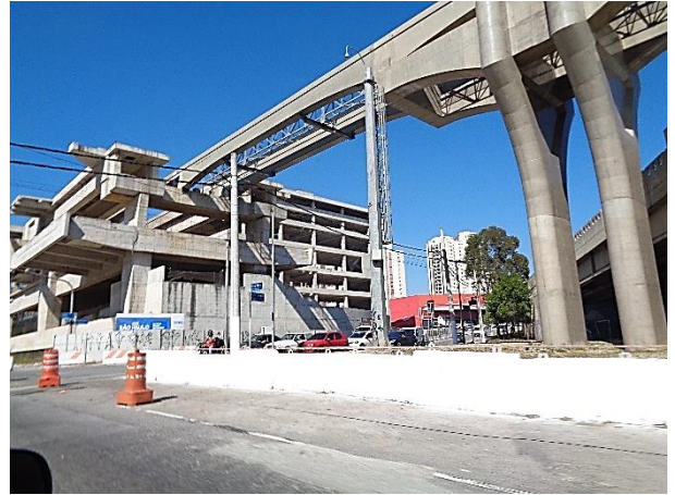
Corpo da Estação: obra bruta.
