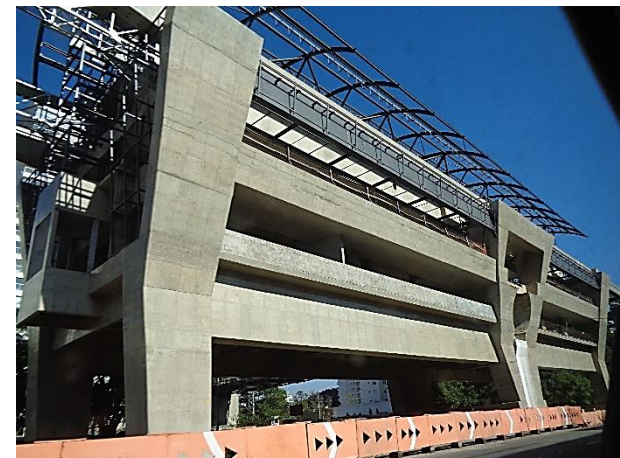
Corpo da Estação: obra bruta.
