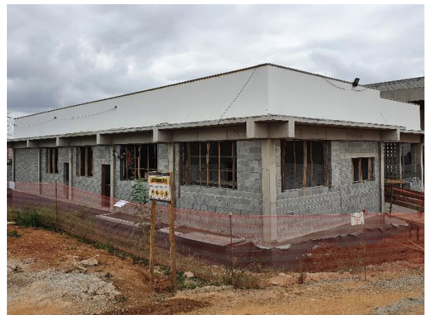
Obra Civil – execução da alvenaria e acabamento da Sala de Controle.
