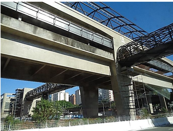
Corpo da Estação: obra bruta.
