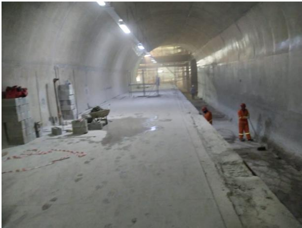
Plataforma – execução do acabamento, instalação de estrutura de luminotécnica, e preparação da borda para instalação das Portas de Plataforma.
