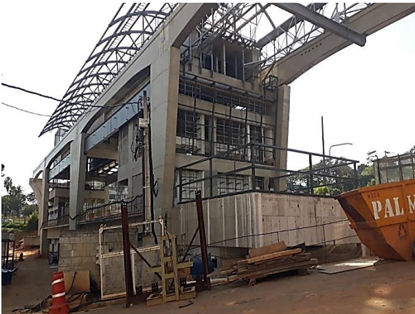
Corpo da Estação: obra bruta.
