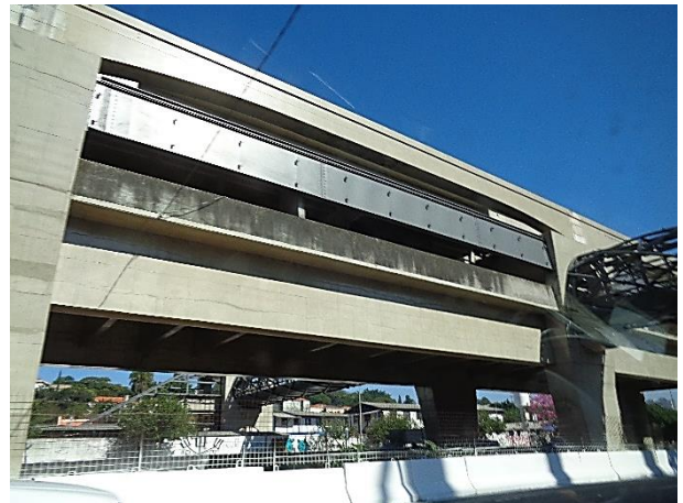
Corpo da Estação: obra bruta.
