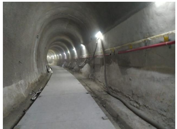
Túnel de Via 05 – execução da laje de regularização para as vias permanentes e instalação da tubulação de incêndio.
