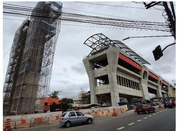
Obra Civil – Execução do primeiro pilar após a Estação e montagem da cobertura metálica da Estação.
