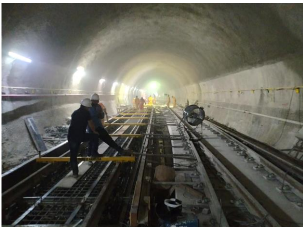
Túnel de Via 07 – em execução a via permanente: instalação de trilhos e de AMV.
