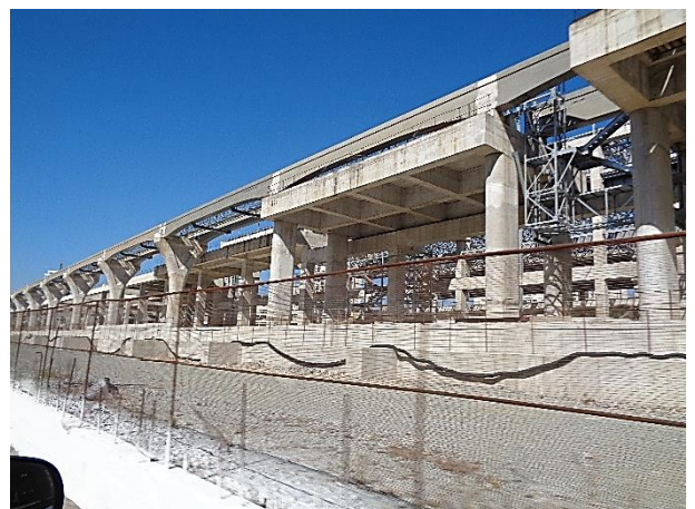
Setor 5 - Estrutura de concreto: obra bruta.
