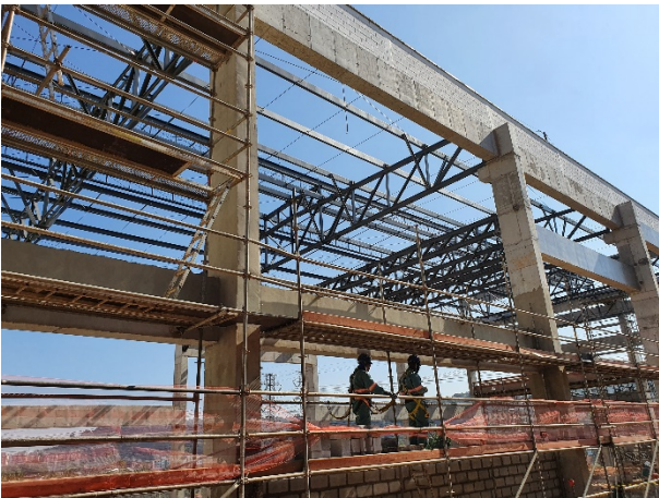
Obra Civil – execução da alvenaria e cobertura metálica da Sala Elétrica.
