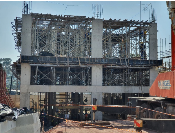
Obra Civil – Montagem de cimbramento da Laje de cobertura das Salas Técnicas 2.
