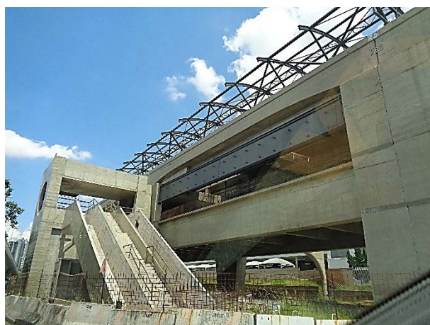
Corpo da Estação: obra bruta.
