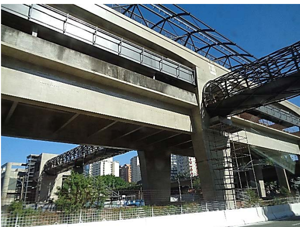
Corpo da Estação: obra bruta.
