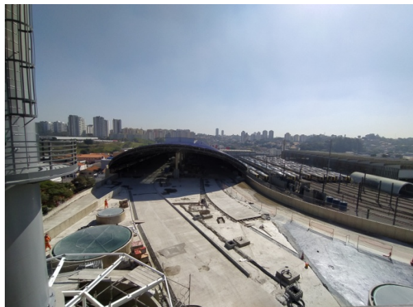
Nível Terminal - execução do pavimento rígido.
