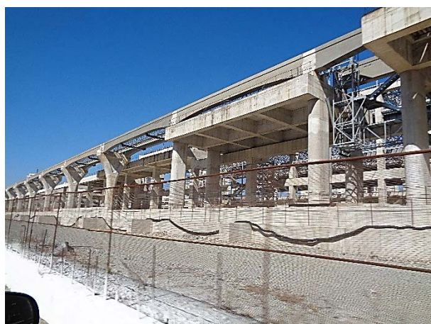
Setor 5 - Estrutura de concreto: obra bruta.
