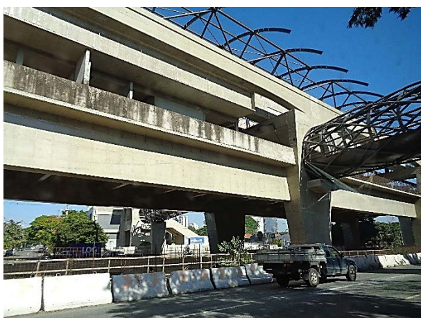
Corpo da estação: obra bruta.
