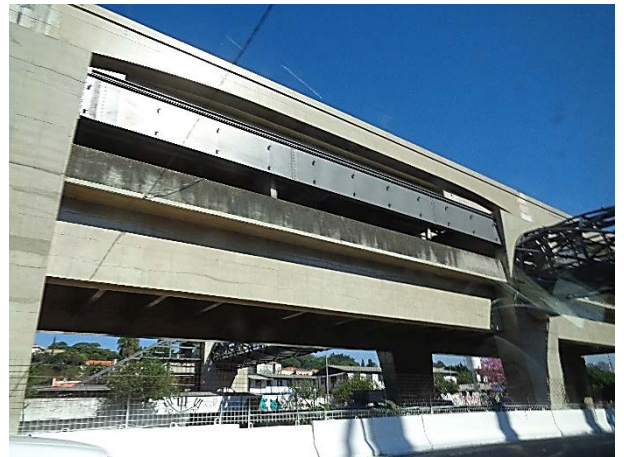
Corpo da Estação: obra bruta.
