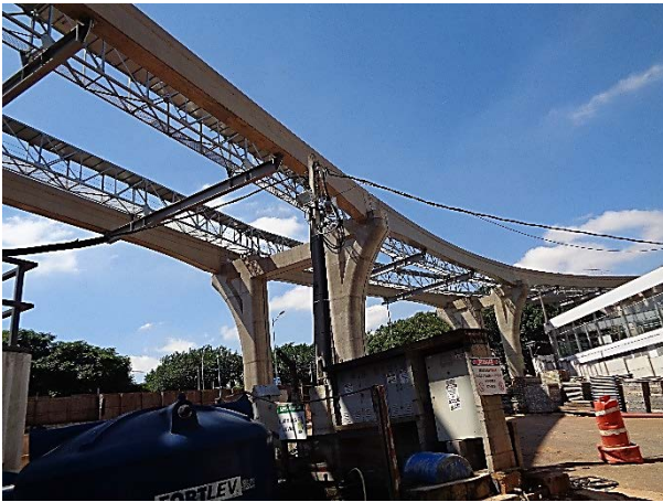
Vias do monotrilho: obra bruta.
