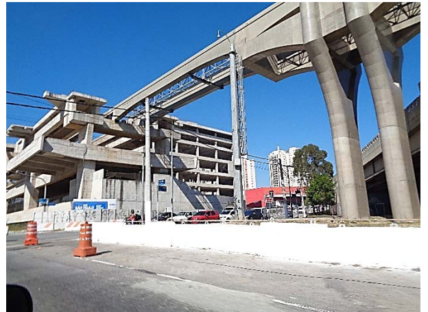
Corpo da Estação: obra bruta.
