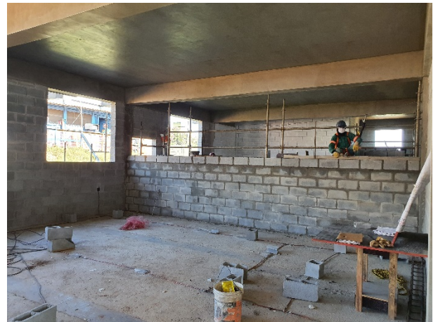
Obra Civil – execução da alvenaria da Sala de Controle.
