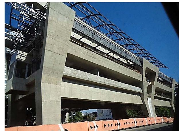
Corpo da Estação: obra bruta.
