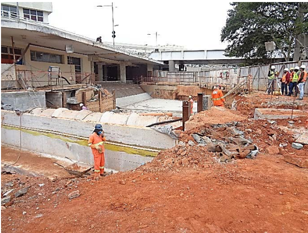
Acesso 2 da Estação: obra bruta.
