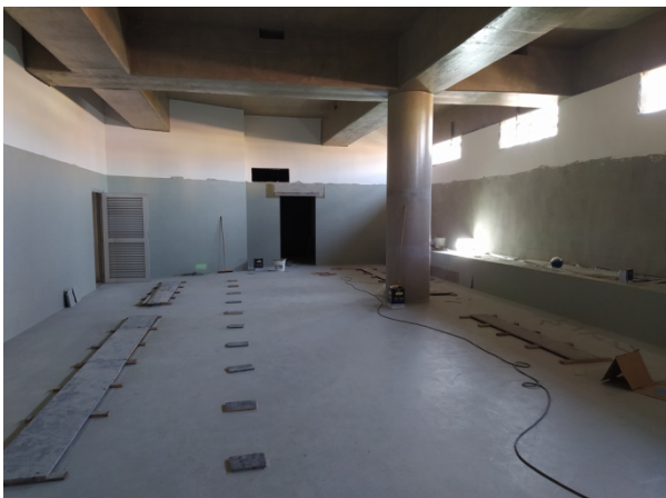
Acesso Heitor dos Prazeres – acabamentos das Salas Técnicas.
