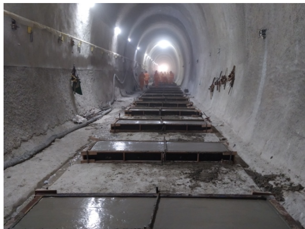
Túnel de Via 05 – execução da laje de regularização para as vias permanentes.
