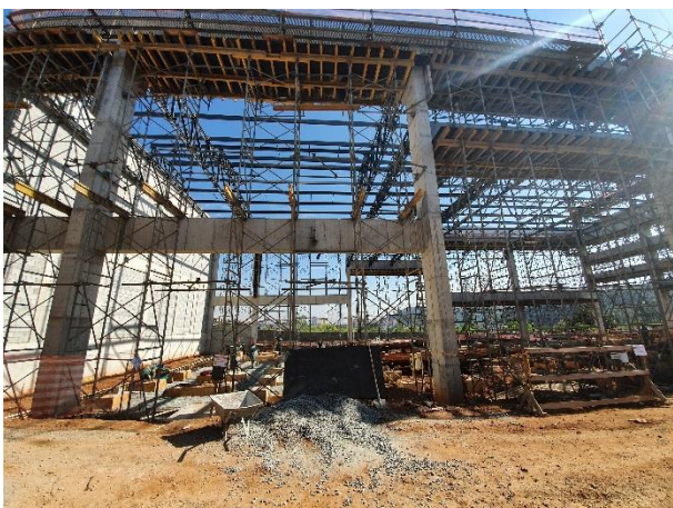
Obra Civil – execução dos pilares, vigas e cobertura metálica da sala Elétrica.
