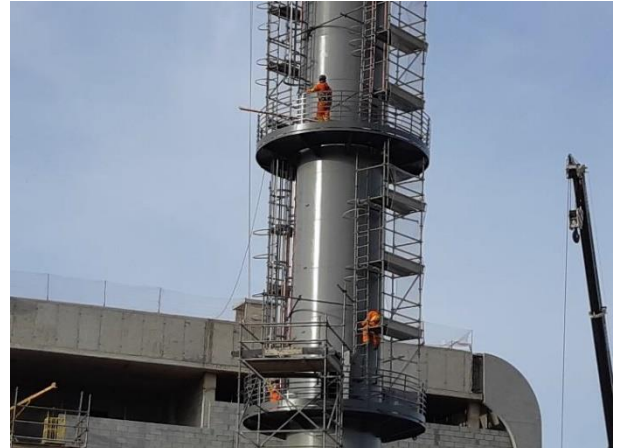
Nível Terminal - execução do reservatório superior do Terminal.
