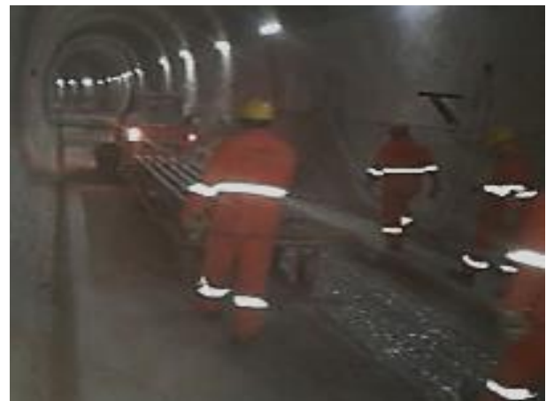
Túnel de Via 05 – transporte do AMV pelo túnel.
