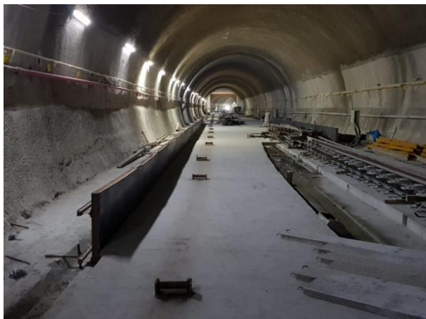
Túnel de Via 02 – em execução laje flutuante.
