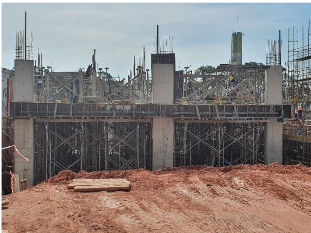
Obra Civil – Montagem de cimbramento da Laje de piso das Salas Técnicas 2.
