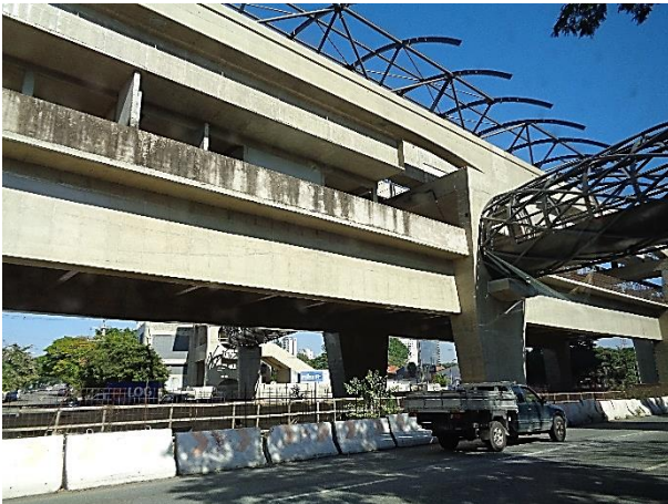
Corpo da estação: obra bruta.
