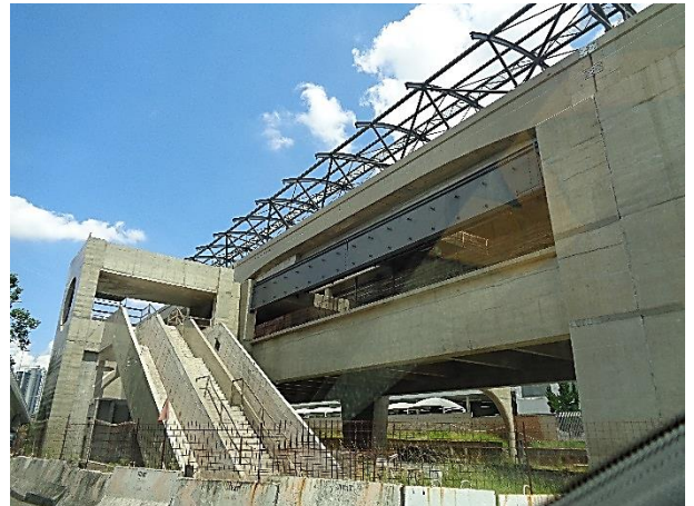
Corpo da Estação: obra bruta.
