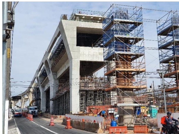
Obra Civil – Execução do primeiro pilar após a Estação.
