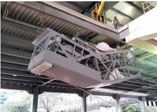
Montagem das Escadas Rolantes.
