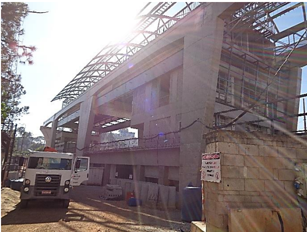
Corpo da Estação: obra bruta.
