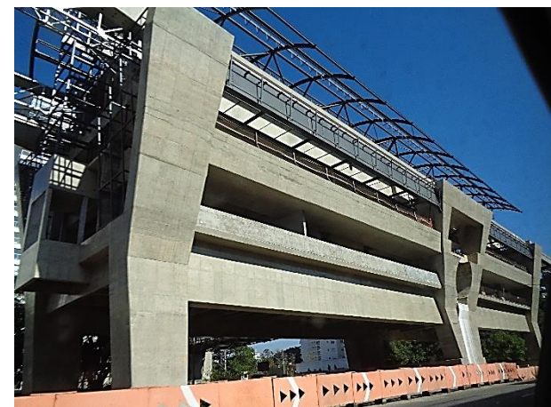
Corpo da Estação: obra bruta.
