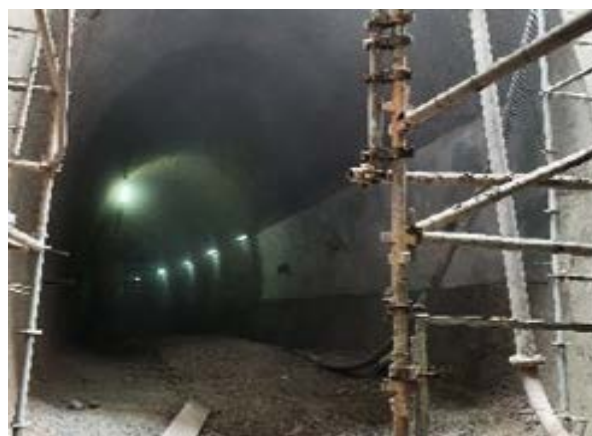
Túnel de Via 05 – em fase de finalização a projeção de concreto do revestimento secundário.
