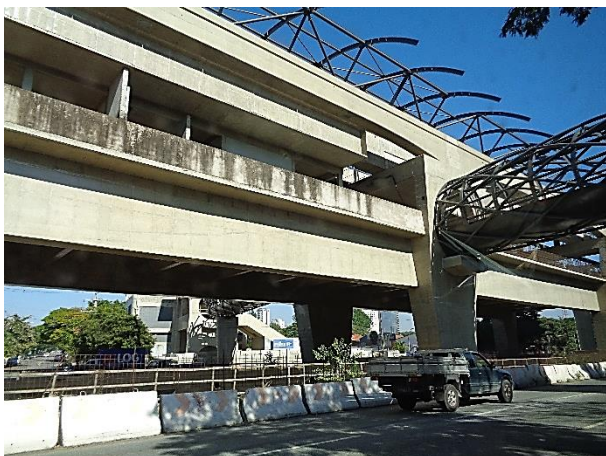
Corpo da estação: obra bruta.
