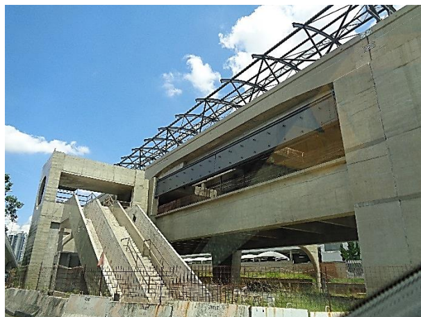
Corpo da Estação: obra bruta.
