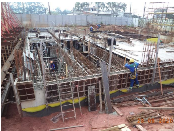
Obra Civil – execução das formas e armação da laje do nível térreo do ETO.
