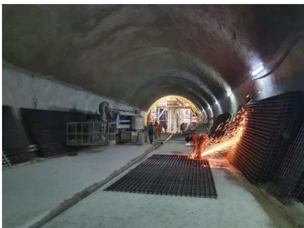
Túnel de Via 02 – em execução laje de regularização para as vias permanentes.
