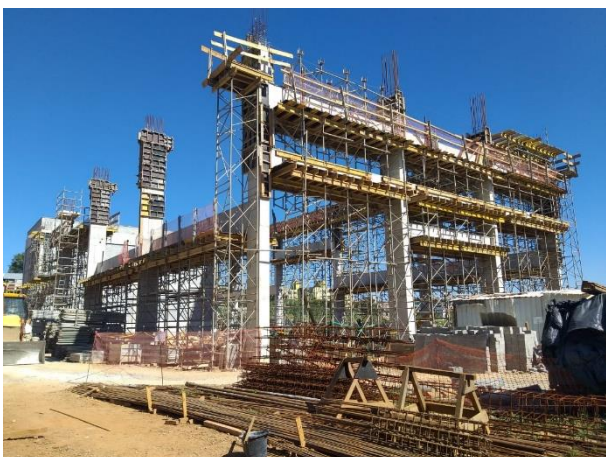
Obra Civil – execução dos pilares e vigas da sala Elétrica.
