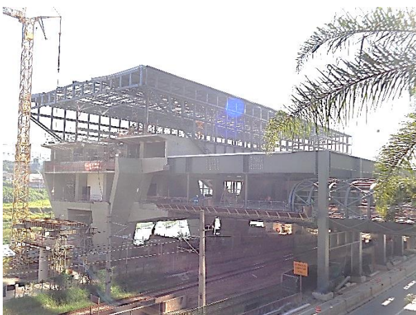
Corpo da Estação e Interligação: obra bruta.
