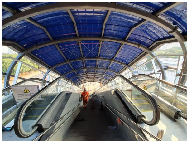
Acesso Eliseu de Almeida: escadas rolantes em instalação elétrica.
