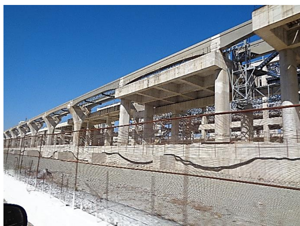
Setor 5 - Estrutura de concreto: obra bruta.
