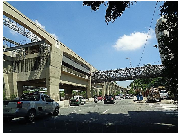
Corpo da Estação: obra bruta.
