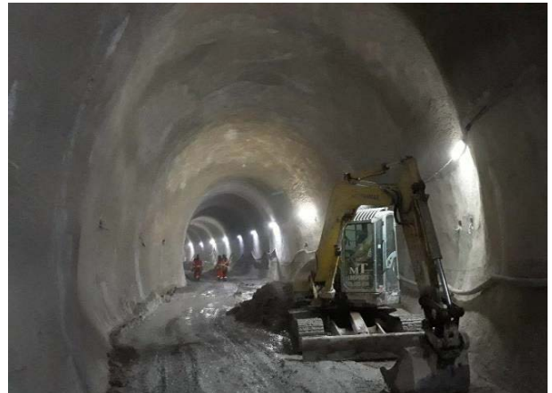
Túnel de Via 05 – em execução revestimento secundário (armação e concreto projetado) na entrada do túnel próximo ao Pátio Vila Sônia.
