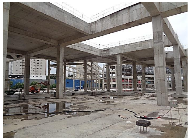
Setor 5 - Estrutura de concreto: obra bruta.
