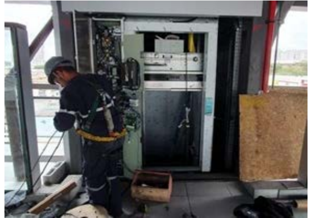
Passarela: elevador em instalação elétrica.
