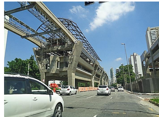
Corpo da Estação: obra bruta.
