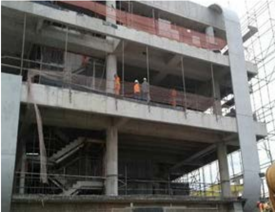
Acesso Heitor dos Prazeres: estruturas internas e acabamentos externos em execução.
