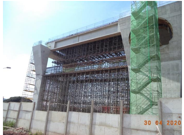
Obra Civil – Em montagem o cimbramento, formas e armação da laje da Plataforma.
