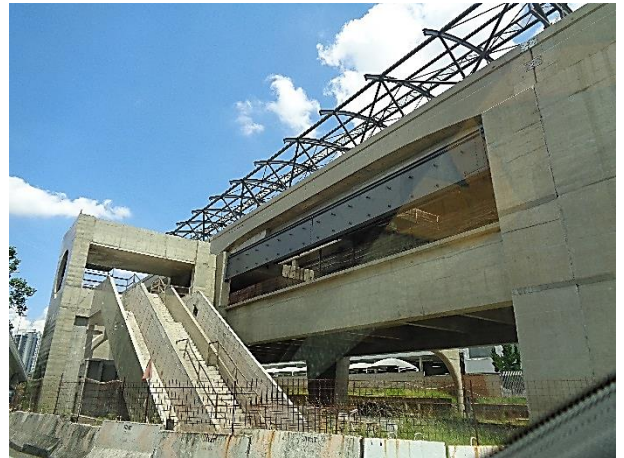
Corpo da Estação: obra bruta.
