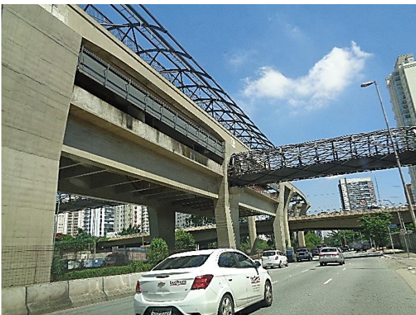
Corpo da Estação: obra bruta.
