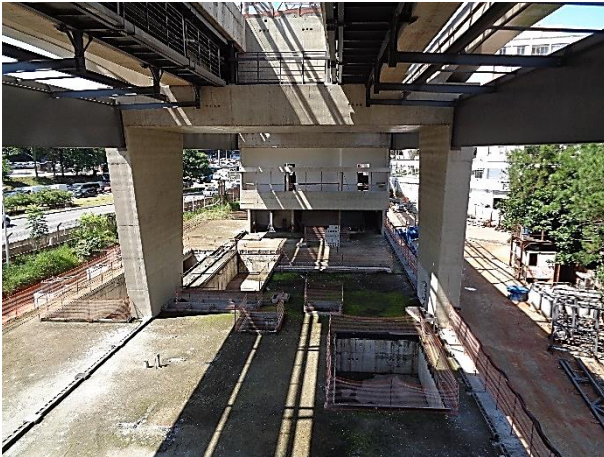
Corpo da Estação: obra bruta.
