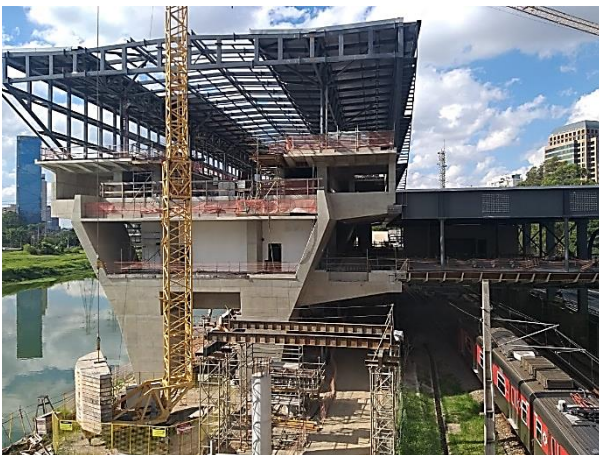
Corpo da Estação: obra bruta.
