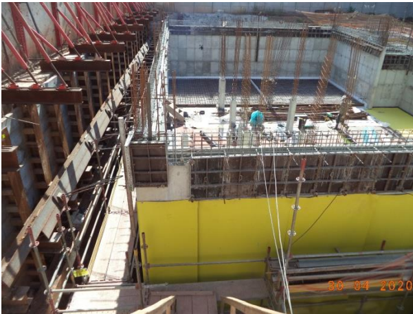
Obra Civil – execução das paredes e impermeabilização do porão de cabos do ETO.
