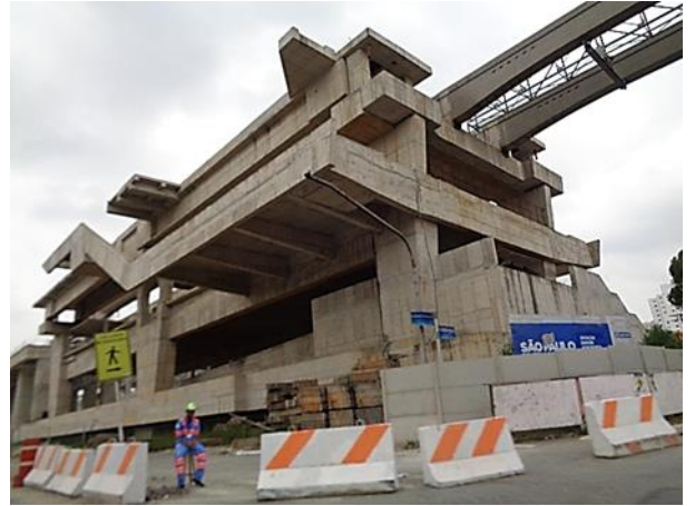
Corpo da Estação: obra bruta.
