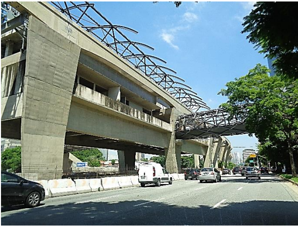
Corpo da estação: obra bruta.
