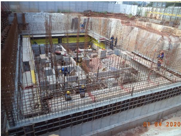
Obra Civil – execução da armação das paredes do porão de cabos do ETO.
