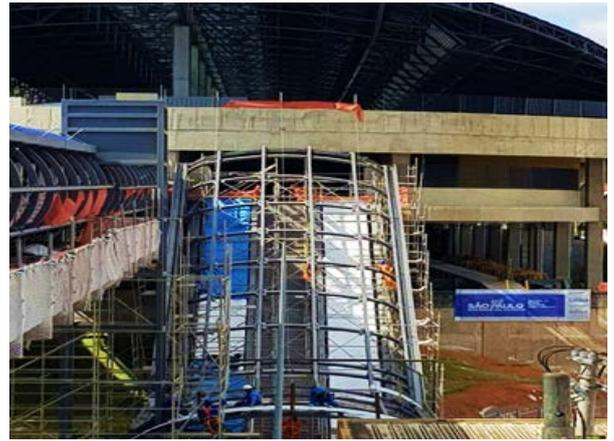
Acessos Heitor dos Prazeres: montagem da estrutura metálica da cobertura sobre as escadas rolantes posicionadas.
