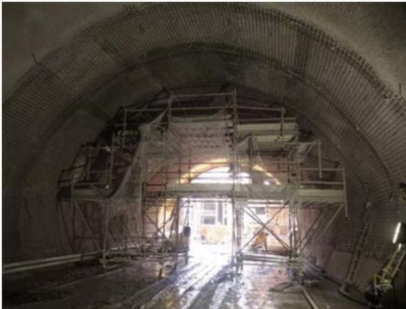
Túnel de Via 02 - em execução o revestimento secundário da calota.
