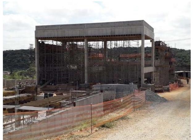
Obra Civil – execução da laje de cobertura da sala de transformadores.
