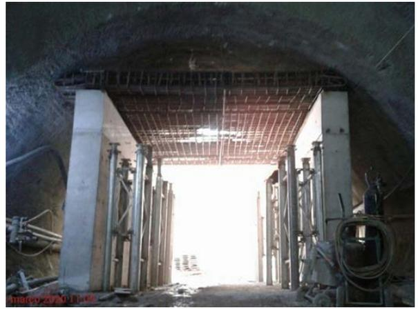
Túnel de Via 05 – em execução as formas e a armação da laje de cobertura.
