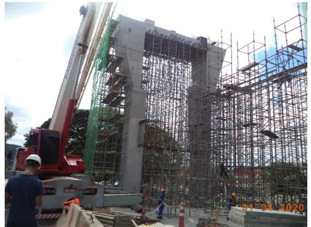
Obra Civil – Pilares do corpo da estação concluídos. Em montagem o cimbramento da laje da Plataforma.
