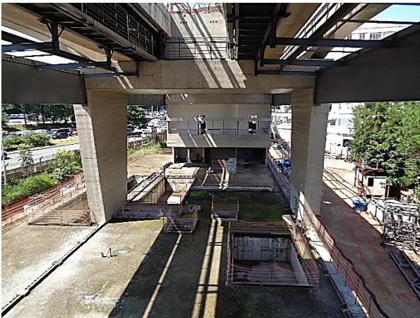
Corpo da Estação: obra bruta.
