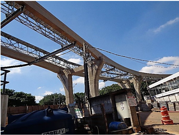
Vias do monotrilho: obra bruta.
