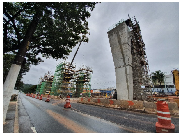
Obra Civil – execução dos pilares do corpo da estação.
