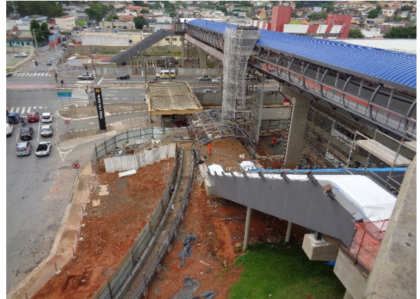
Acessos Heitor dos Prazeres e Eliseu de Almeida: Acabamentos externos em execução; 4 escadas rolantes dos acessos posicionadas.
