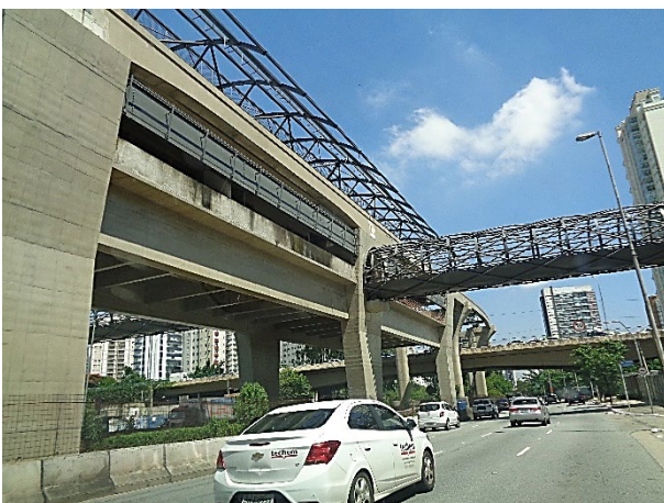
Corpo da Estação: obra bruta.
