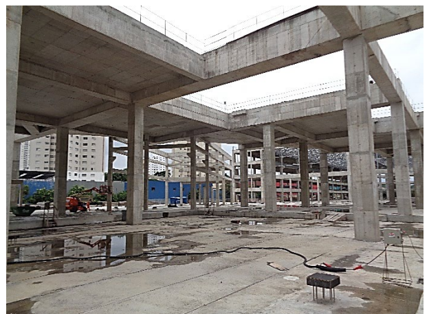
Setor 5 - Estrutura de concreto: obra bruta.
