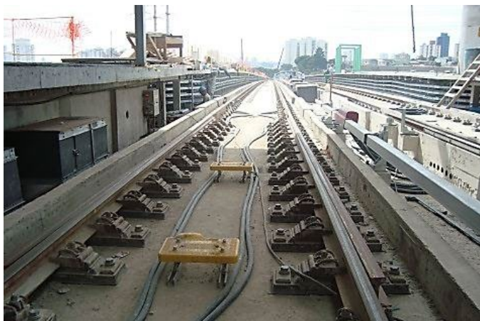
Equipamentos na via
