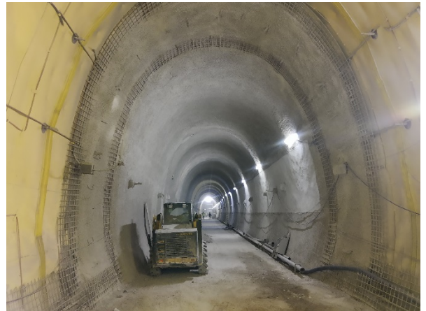
Túnel de Via 05 - em execução o revestimento secundário da calota.
