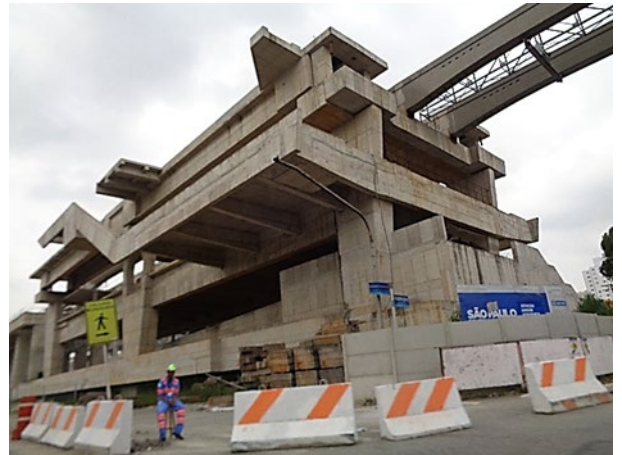
Corpo da Estação: obra bruta.
