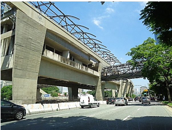
Corpo da estação: obra bruta.
