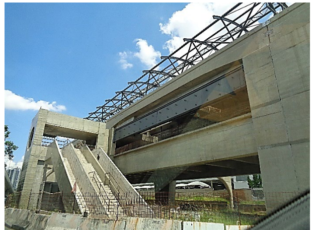
Corpo da Estação: obra bruta.
