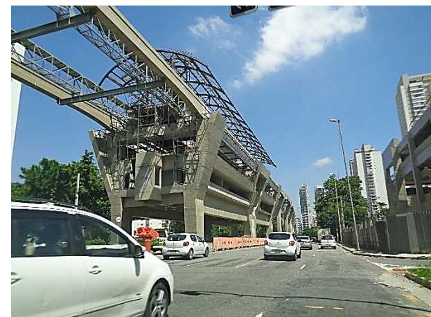
Corpo da Estação: obra bruta.
