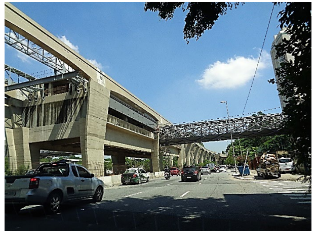
Corpo da Estação: obra bruta.
