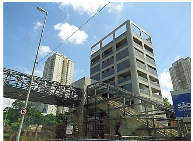
Acesso da Estação: estrutura metálica.
