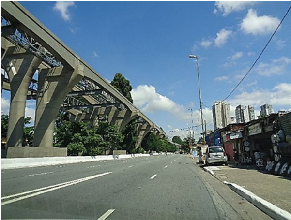
Vias do monotrilho: obra bruta.
