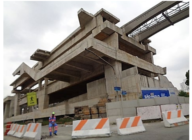
Corpo da Estação: obra bruta.
