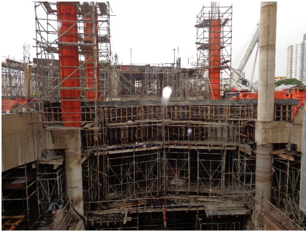
Acesso Heitor dos Prazeres – em execução as estruturas internas das edificações das Salas Técnicas.
