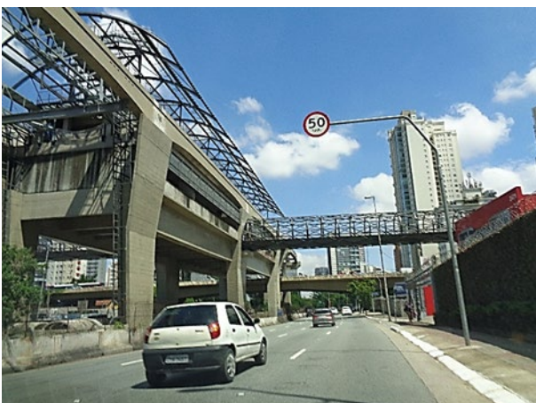
Passarela de Acesso.
