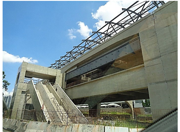
Corpo da Estação: obra bruta.
