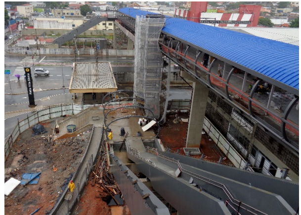
Execução da cobertura e dos pisos da passarela, e acabamentos externos dos Acessos Heitor dos Prazeres e Eliseu de Almeida.
