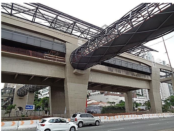
Corpo da Estação: obra bruta.
