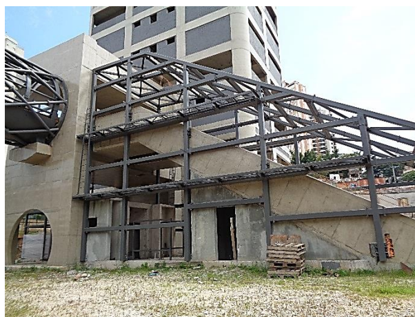
Acesso da Estação: estrutura metálica e obra bruta.
