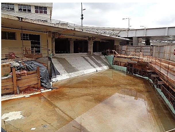
Acesso 2 ao aeroporto de Congonhas: obra bruta
