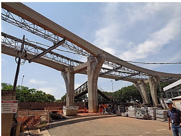
Vias do monotrilho: obra bruta.
