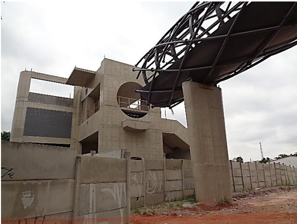
Acesso da Estação: estrutura metálica
