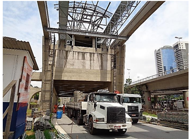
Corpo da Estação: obra bruta.
