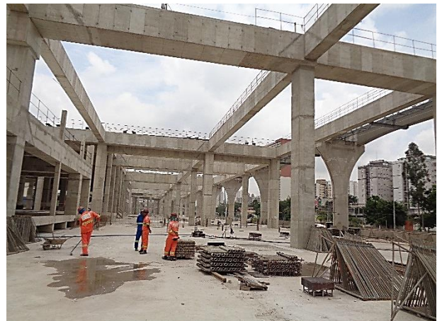
Setor 5 - Estrutura de concreto em andamento.
