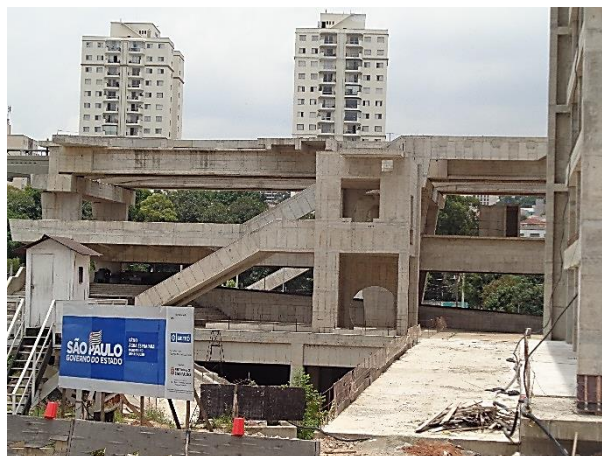
Corpo da Estação – Obra bruta.
