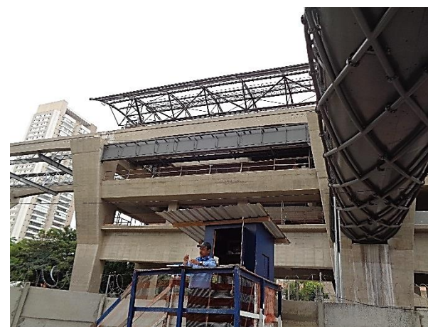
Corpo da Estação: estrutura metálica.
