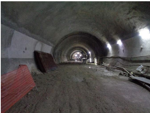
Túnel de Via 04 - em execução a impermeabilização e o revestimento secundário da calota.
