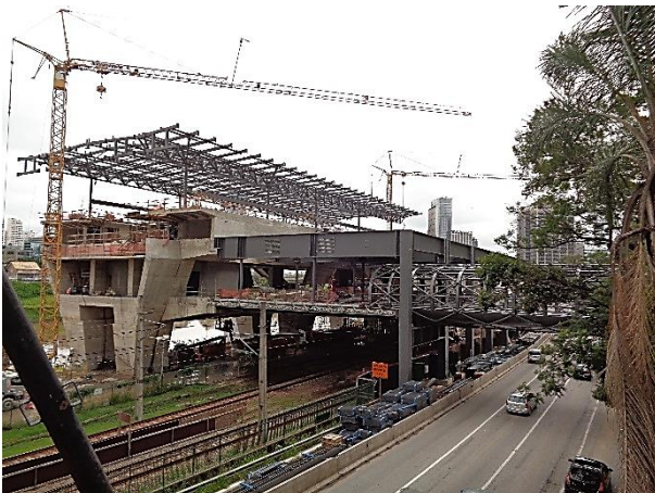
Corpo da Estação – Estrutura metálica e interligação com CPTM em andamento.
