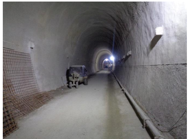
Túnel de Via 05 - em execução a impermeabilização e o revestimento secundário da calota.
