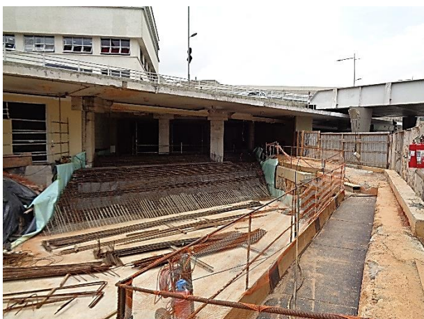
Acesso 2 ao aeroporto de Congonhas: obra bruta
