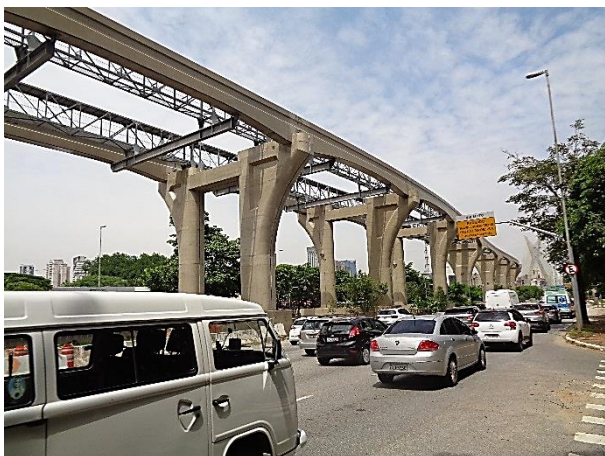
Execução das vias do monotrilho paralisada.
