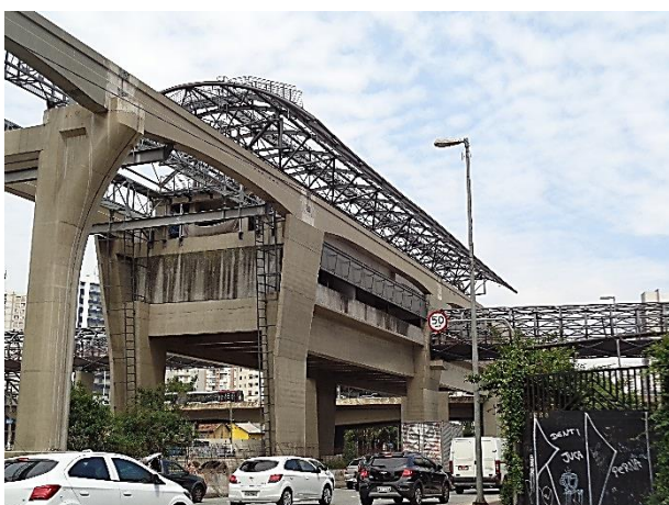
Corpo da Estação: obra bruta.
