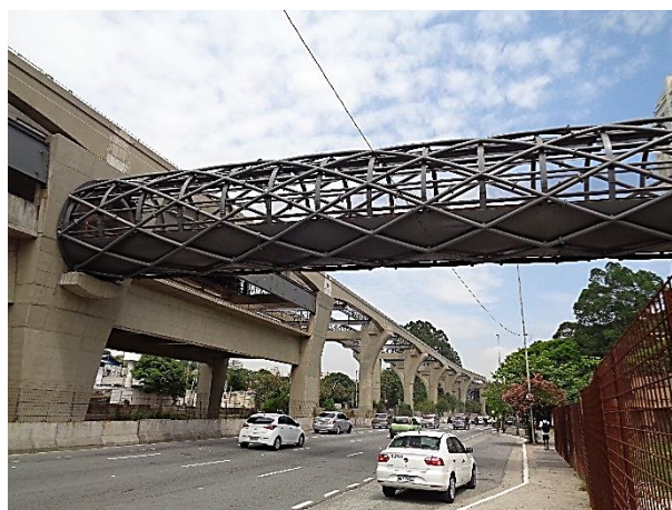
Corpo da Estação: estrutura metálica e obra bruta.
