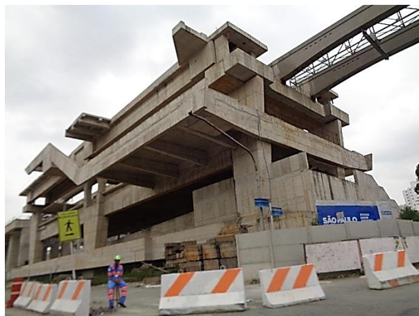
Corpo da Estação – Obra bruta concluída. Em fase de recontração das obras complementares.
