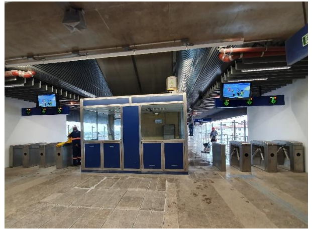
Obra Civil – execução da limpeza do mezanino. Sistemas – em fase final implantação e testes.
