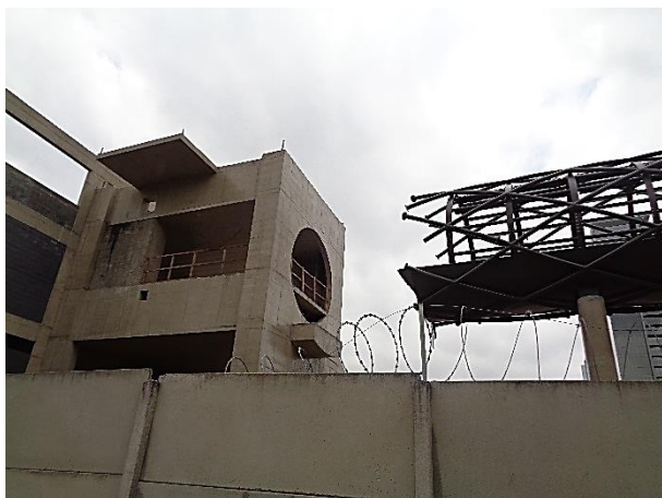
Corpo da Estação: estrutura metálica
