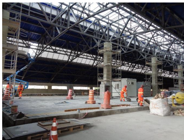
Execução do ladrilho hidráulico do passeio do Terminal.
