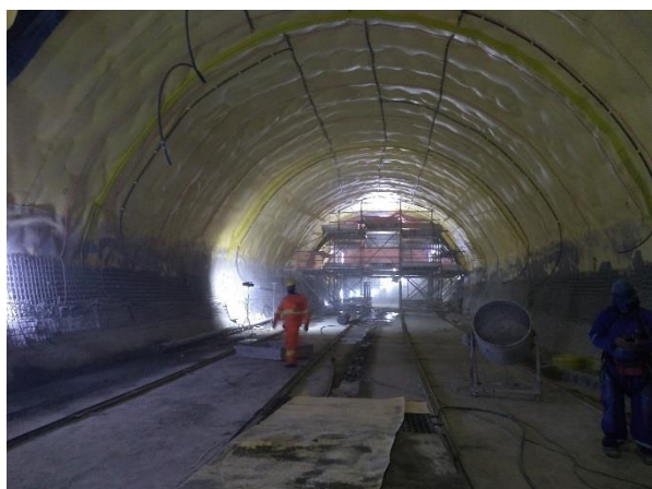
Túnel de Via 04 - em execução a impermeabilização da calota.
