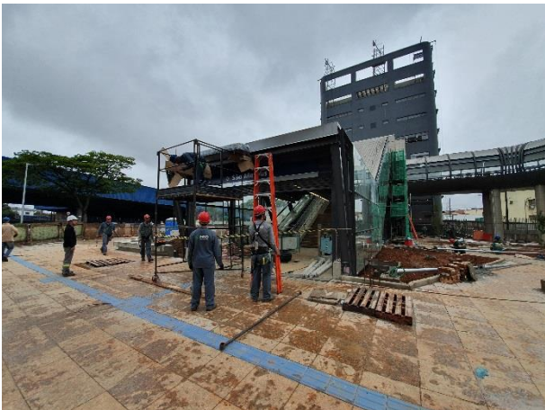
Obra Civil – instalação do piso e urbanização do Acesso Sul. Sistemas – montagem dos painéis de LED e da iluminação externa.
