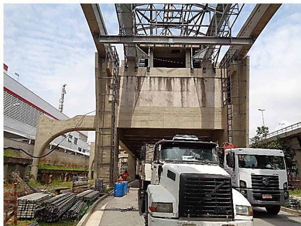
Corpo da Estação: obra bruta.
