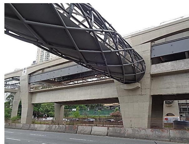
Corpo da Estação: estrutura metálica.
