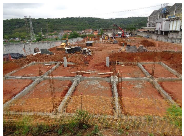
Obra Civil – execução dos blocos de fundação.
