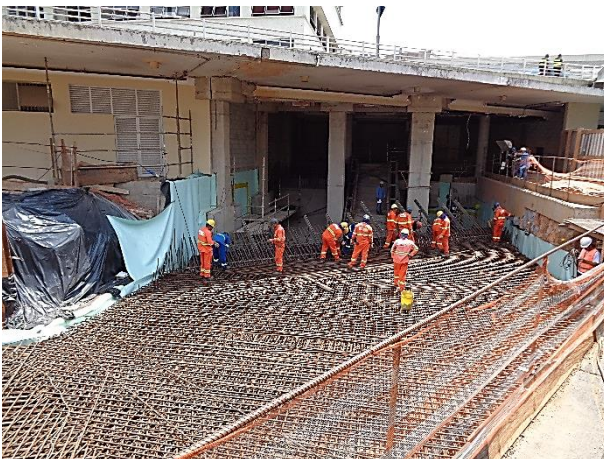
Acesso 2 ao aeroporto de Congonhas: obra bruta
