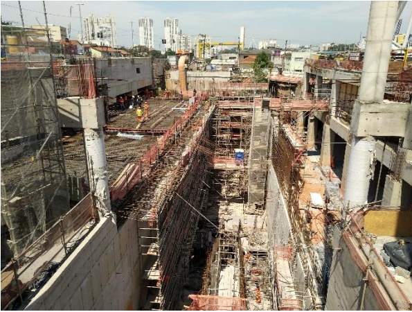
Acesso Heitor dos Prazeres – em execução as estruturas internas.
