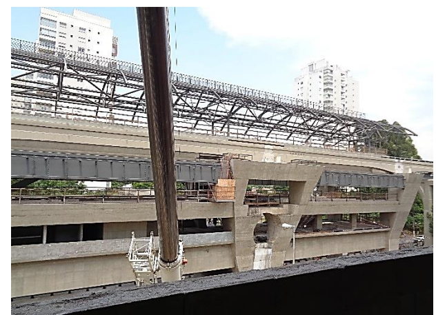
Corpo da Estação: obra bruta.
