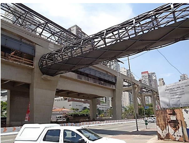
Corpo da Estação: estrutura metálica.
