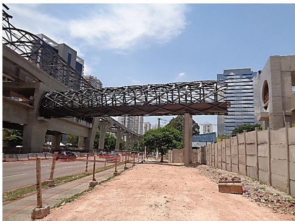
Corpo da Estação: estrutura metálica
