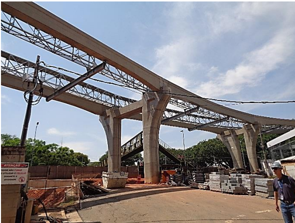
Execução das vias do monotrilho paralisada.
