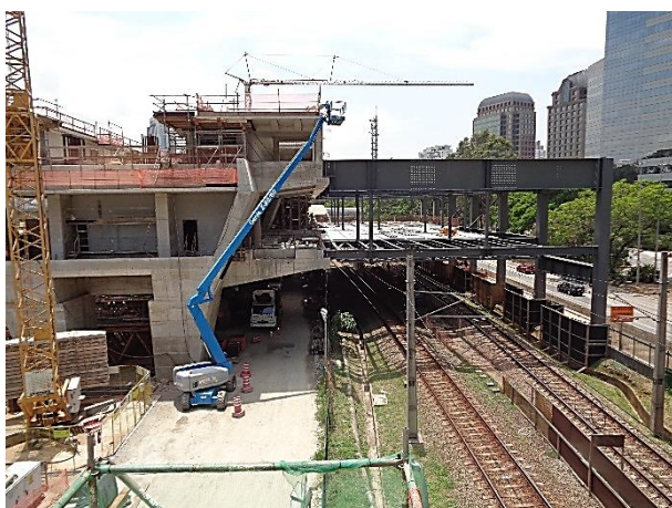
Corpo da Estação – Lajes da plataforma e interligação com CPTM em andamento.
