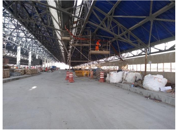
Execução dos arremates da cobertura.
