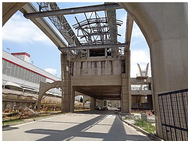
Corpo da Estação: obra bruta.
