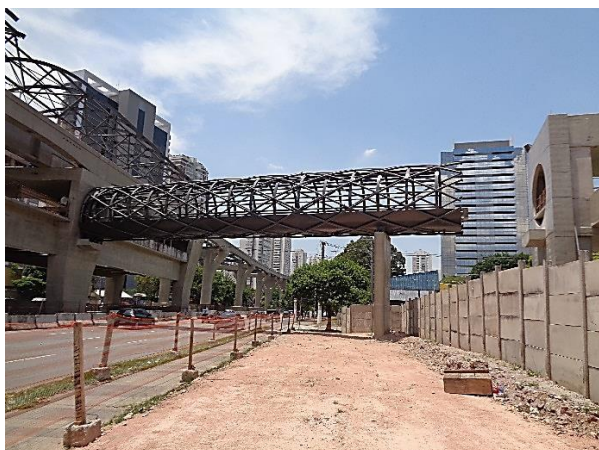
Corpo da Estação: estrutura metálica
