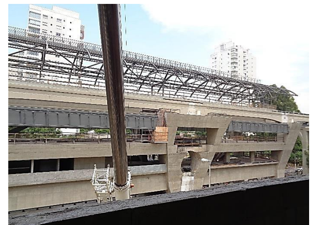
Corpo da Estação: obra bruta.
