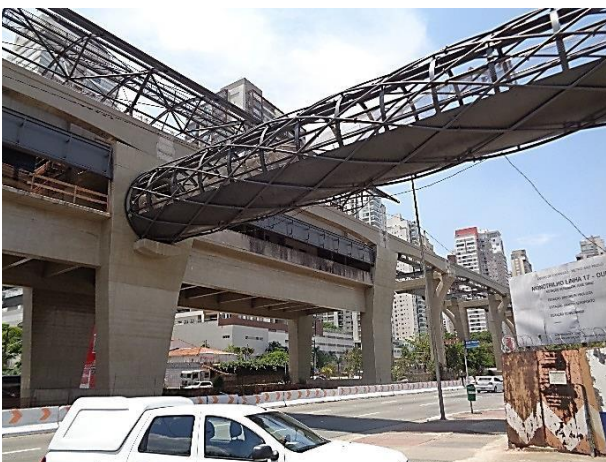
Corpo da Estação: estrutura metálica.
