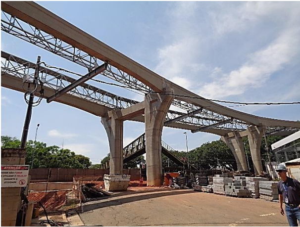
Execução das vias do monotrilho paralisada.
