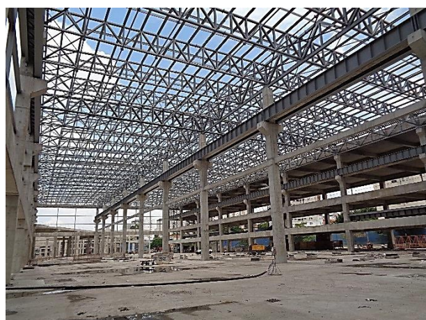
Bloco A - Estrutura da cobertura do bloco em andamento.
