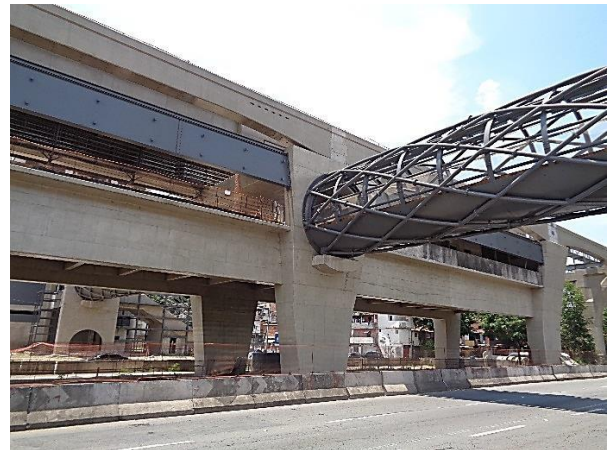
Corpo da Estação: estrutura metálica e obra bruta.
