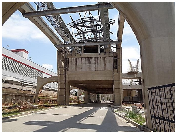
Corpo da Estação: obra bruta.
