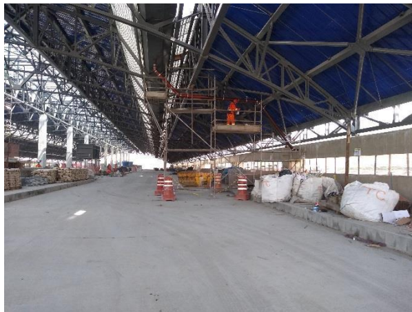
Execução dos arremates da cobertura.
