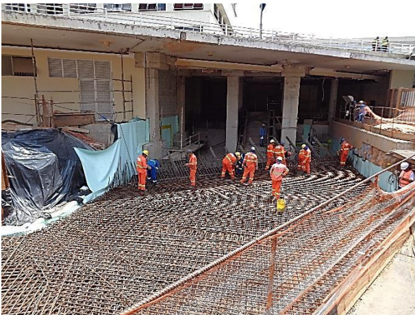
Acesso 2 ao aeroporto de Congonhas: obra bruta
