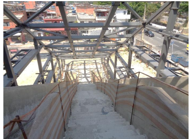
Acesso da Estação: estrutura metálica e obra bruta.
