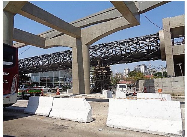
Acesso: estrutura metálica em andamento.
