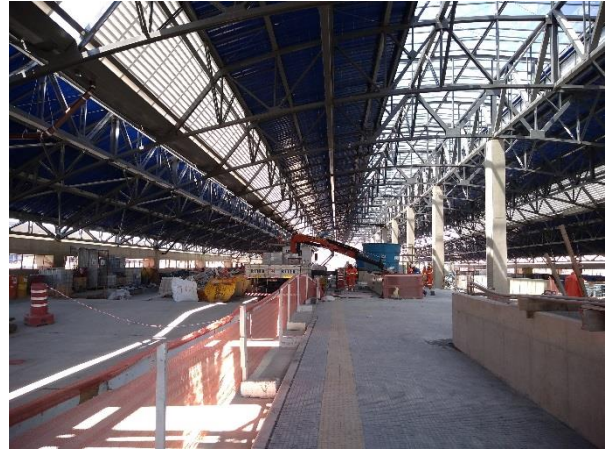
Instalação dos fechamentos da cobertura metálica e instalação do piso no passeio.
