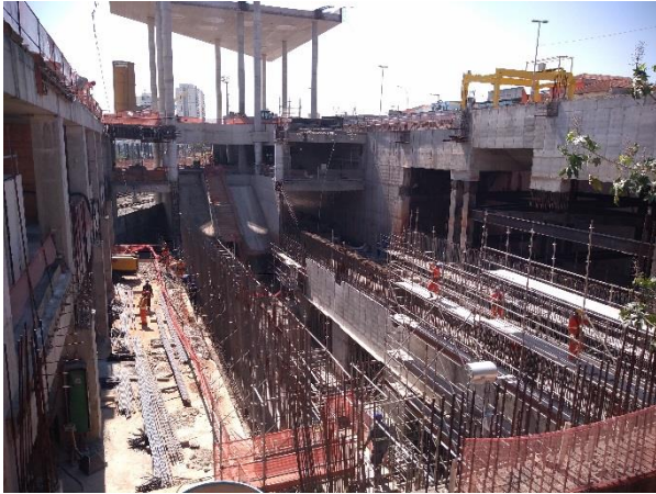
Acesso Heitor dos Prazeres – estruturas internas.
