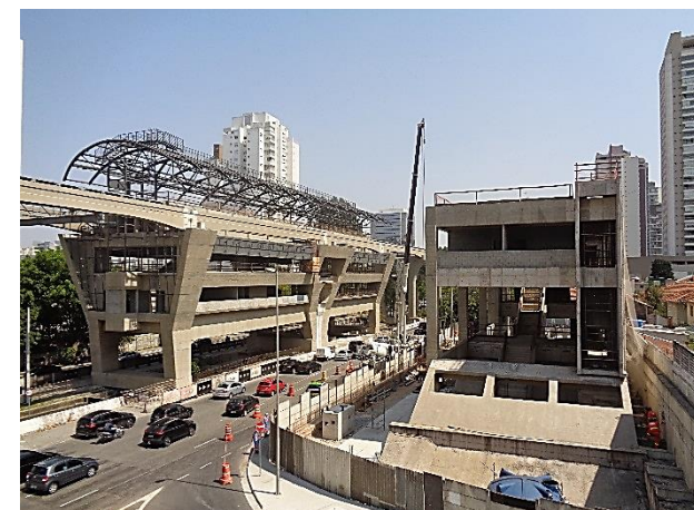
Corpo da Estação e acesso: obra bruta.
