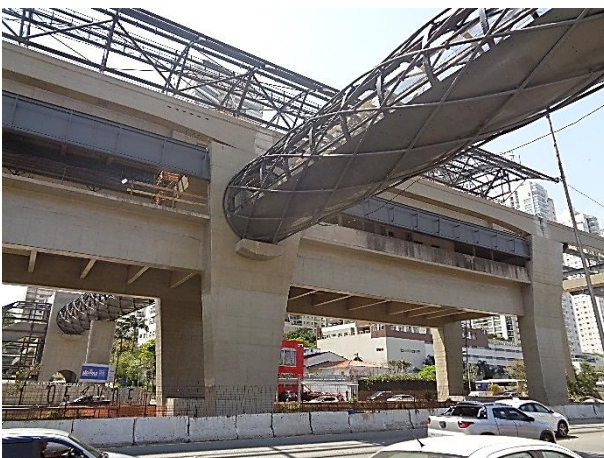
Corpo da Estação: estrutura metálica.
