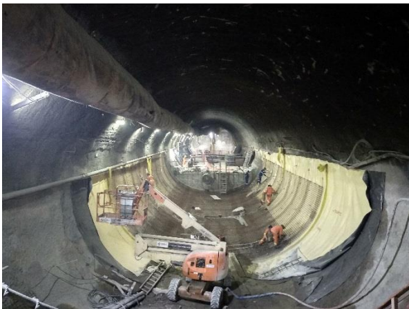
Túnel de Via 04 - em execução a impermeabilização do invert.
