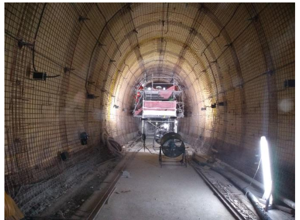
Túnel de Via 05 - em execução a impermeabilização e o revestimento secundário.
