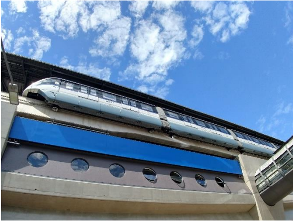
Trem em operação na Estação Vila Tolstói.
