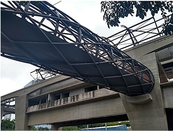
Corpo da Estação: estrutura metálica
