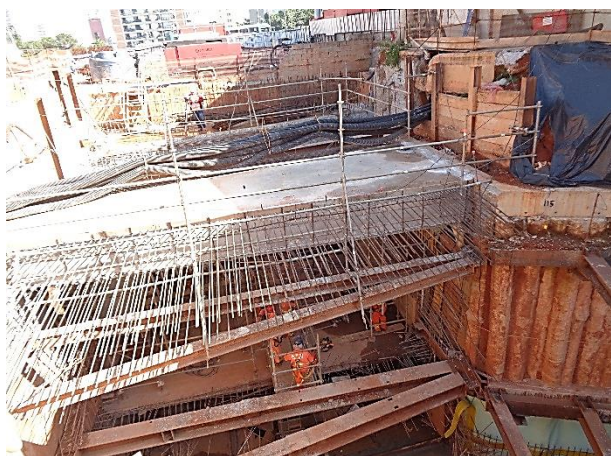
Acesso ao Aeroporto - Execução de laje do acesso.
