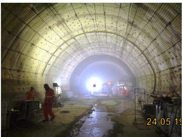
Túnel de Via 07 (Duplo – SE David Matarazzo – Fim do Prolongamento): Em execução impermeabilização e revestimento secundário.
