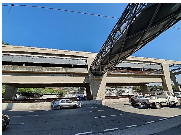
Montagem da estrutura metálica em andamento.
