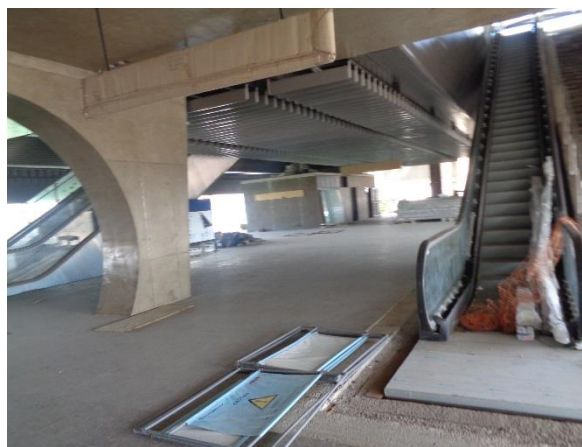
Obra civil – aplicação do verniz no concreto aparente e implantação dos Sistemas.
