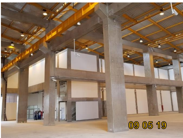
Bloco F: Concluído. Em Checklist com CVQ para formalização da entrega.
