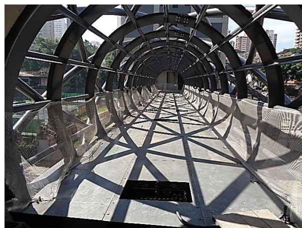
Montagem da estrutura metálica em andamento.
