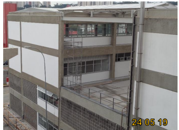
Bloco B/m: Concluído. Em Checklist com CVQ para formalização da entrega.
