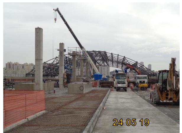
Nível Terminal (Terminal de Ônibus Vila Sônia): Em montagem a cobertura metálica.
