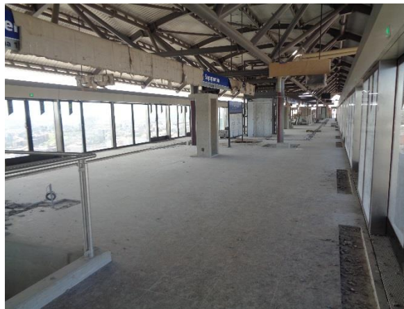
Obra Civil – arremates no piso de granito da plataforma e implantação dos Sistemas.
