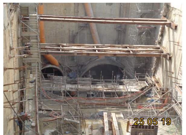
VSE Edmundo Lins: Em execução impermeabilização e revestimento secundário. Emboque dos túneis Singelo (Túnel 5) e Duplo (Túnel 4).
