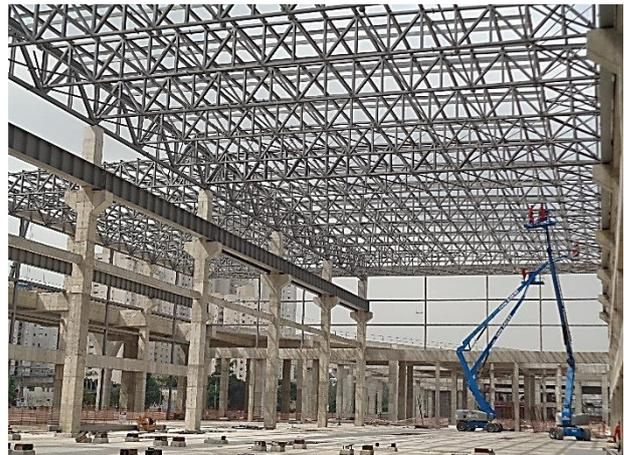
Em execução cobertura metálica do Bloco A.
