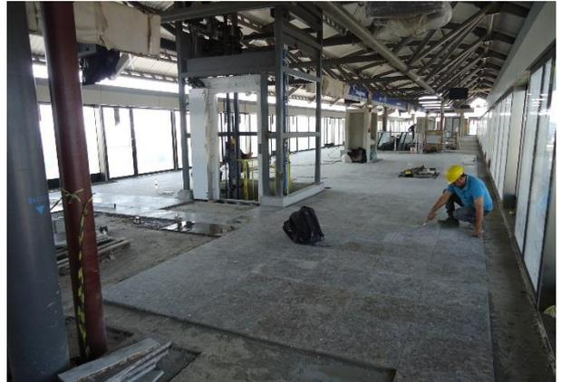
Obra Civil – instalação de piso de granito na plataforma e implantação de Sistemas
