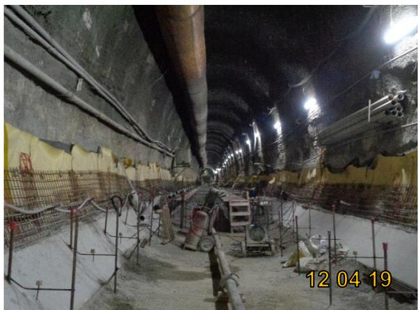
**Túnel de Via 05 (Singelo - Poço Valter Seng - VSE Edmundo Lins):** Em execução impermeabilização e revestimento secundário.
