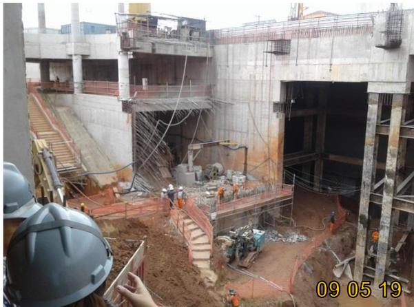
**Corpo de Estação:** Escavação sob a laje de cobertura da estação pelo Acesso Heitor dos Pátio Vila Sônia
