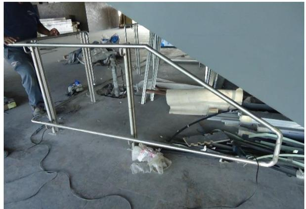
Obra civil – polimento do guarda corpo no mezanino e implantação dos Sistemas
