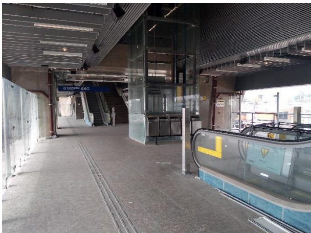
Vista interior da estação.
