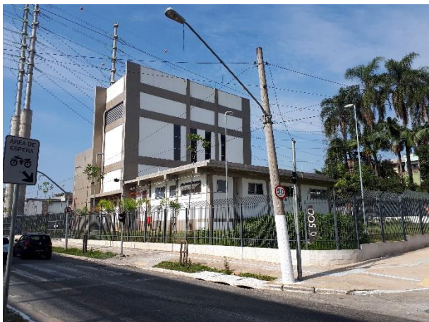
Vista da Subestação.
