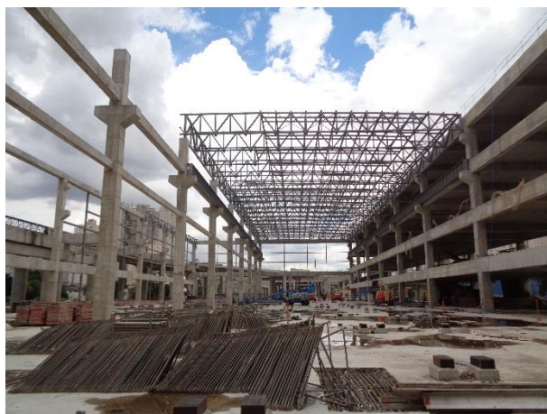
Em execução cobertura metálica do Bloco A.
