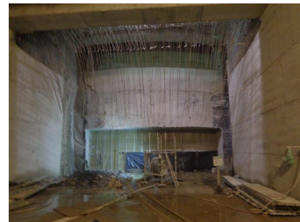
Vista do futuro acesso para Linha 5.
