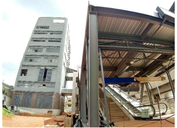
Em andamento a implantação dos Sistemas.
