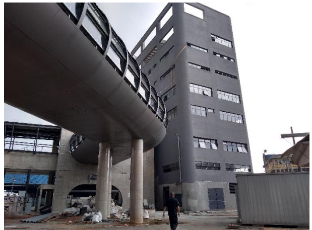
Em andamento a implantação dos Sistemas.
