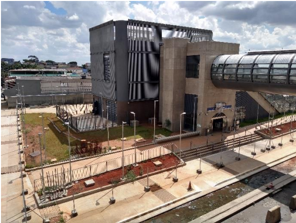
Vista geral da estação.
