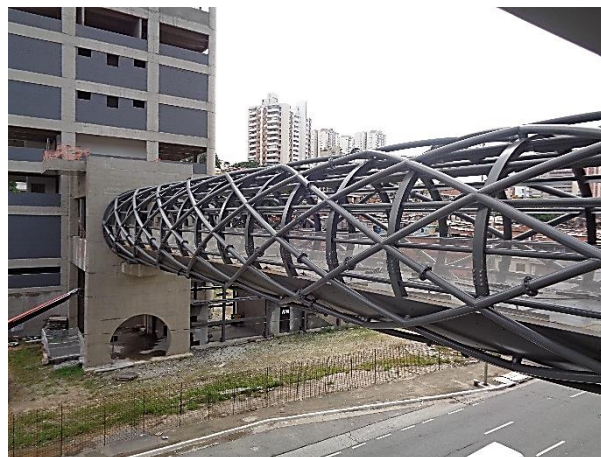
Passarela Metálica e Acesso.
