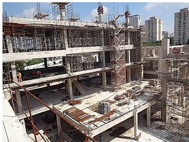
Em execução os pilares e estruturas internas do Bloco B.
