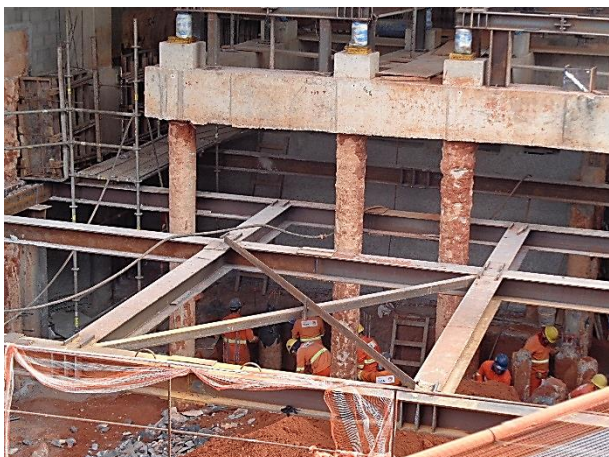
Acesso ao Aeroporto - Execução da transferência de cargas.
