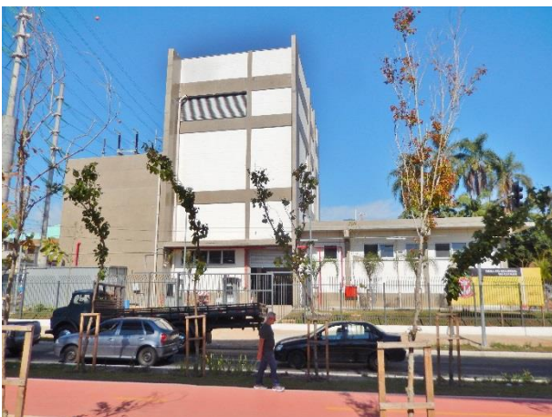
Vista frontal da Subestação.
