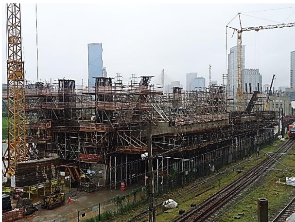
Execução dos pilares e laje do mezanino da estação.
