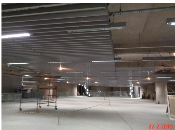
Mezanino Intermediário: luminárias instaladas e forro em instalação.
