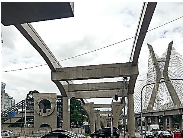
Vista geral das vias do monotrilho
