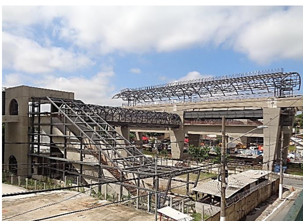
Visão geral da estação.
