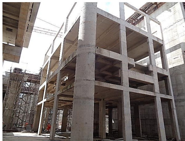
Vista geral da estação
