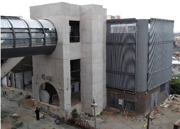
Em andamento a implantação dos Sistemas.
