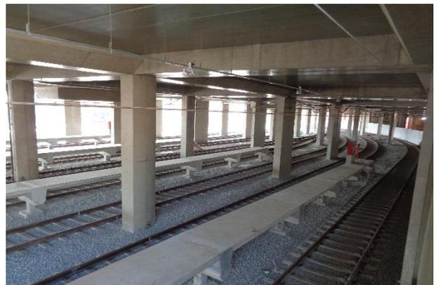
**Nível Pátio (Terminal de Ônibus Vila Sônia):** Vias Permanentes, AMVs (Feixe de entrada vias 1 a 10), iluminação e rede aérea instalados.
