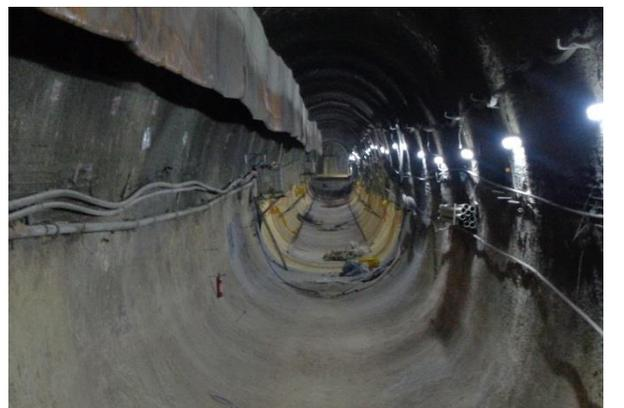
**Túnel de Via 05:** em escavação e impermeabilização e revestimento secundário em execução.
