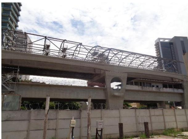
Corpo da estação – Montagem da cobertura metálica.
