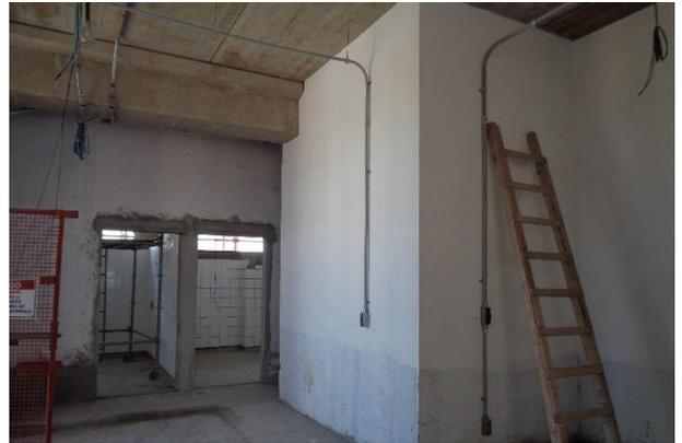
**Bloco B/m:** Instalação de infraestrutura para passagens de cabos de iluminação e tomadas
