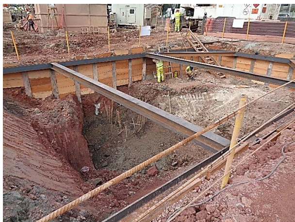
Execução das fundações da Estação.
