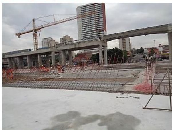
Execução da laje sobre o piscinão
