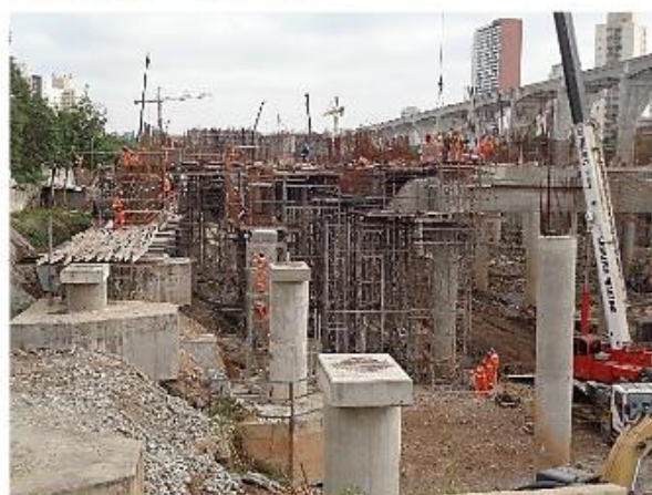
Execução das vigas sobre o piscinão.
