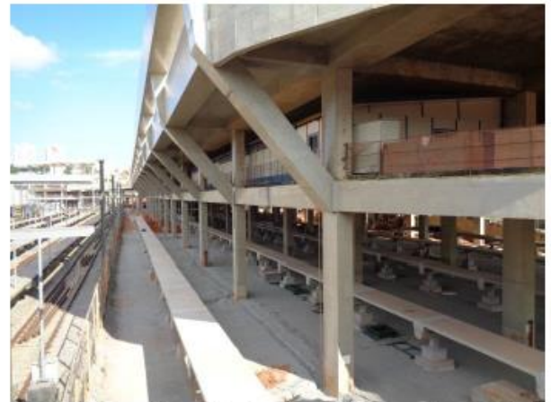
Nível Pátio (Terminal de Ônibus Vila Sônia): Plataformas de acesso aos trens e reaterro em execução. Infraestrutura para rede aérea em instalação.
