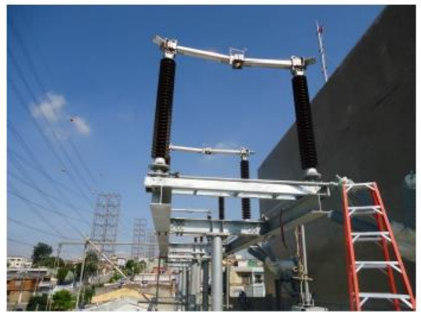
Montagem das seccionadoras e para-raios de entrada
