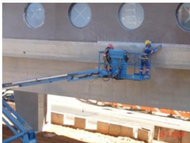
Arremate das pastilhas externas do Corpo da Estação.
