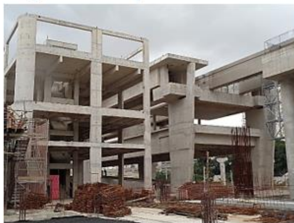
Edifício Operacional e Corpo da Estação (esta estação possui plataformas laterais) – Obra Bruta concluída.
