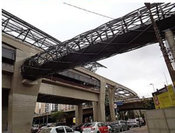
Montagem da estrutura metálica do acesso da Estação.
