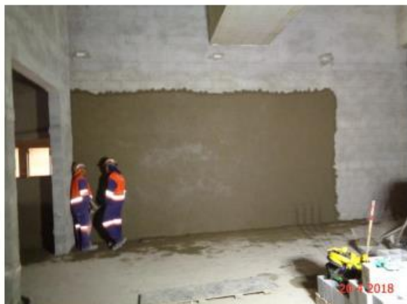
Corpo da estação – Poço 5: Revestimento de parede nas salas técnicas
