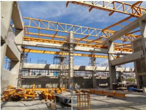
Bloco F: Cobertura Metálica em execução.
