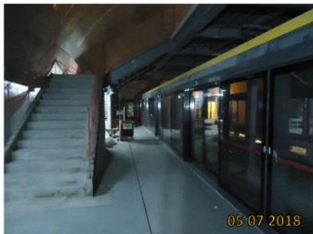
Corpo da Estação: Portas de Plataforma (Header Box e Vidros) em comissionamento. Escadas fixas do mezanino metálico em concretagem.
