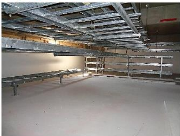
Execução do bandejamento de cabos
