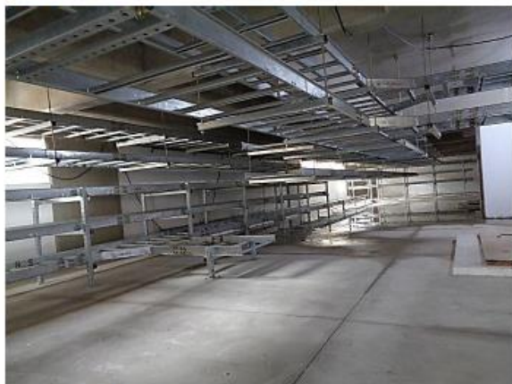
Instalação do bandejamento.
