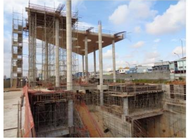
Acesso Heitor dos Prazeres: laje de cobertura do acesso parcialmente executada.
