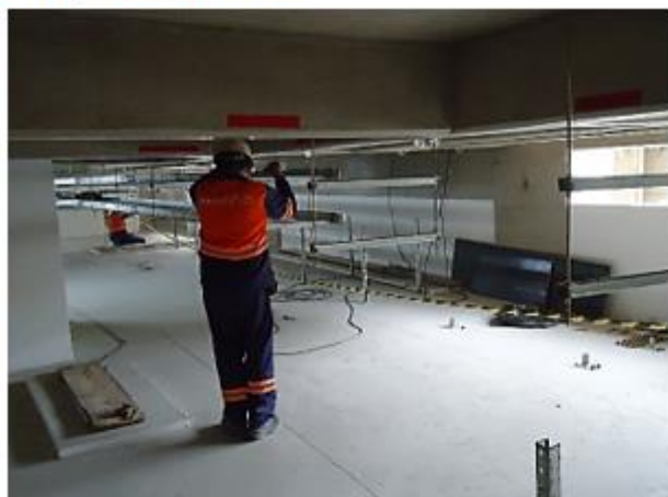
Execução do bandejamento de cabos
