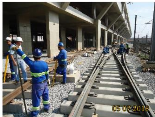
Nível Pátio (Terminal de Ônibus Vila Sônia): Vias Permanentes e AMVs (Feixe de entrada vias 6 a 10) em instalação.
