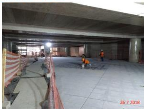
Mezanino Inferior: Assentamento do porcelanato em execução
