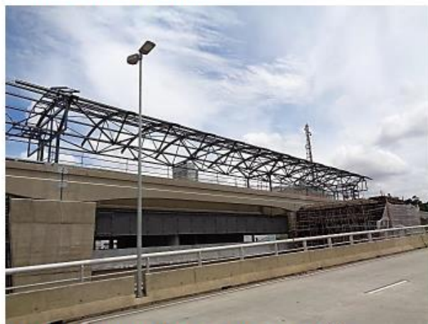
Montagem da cobertura metálica da Estação
