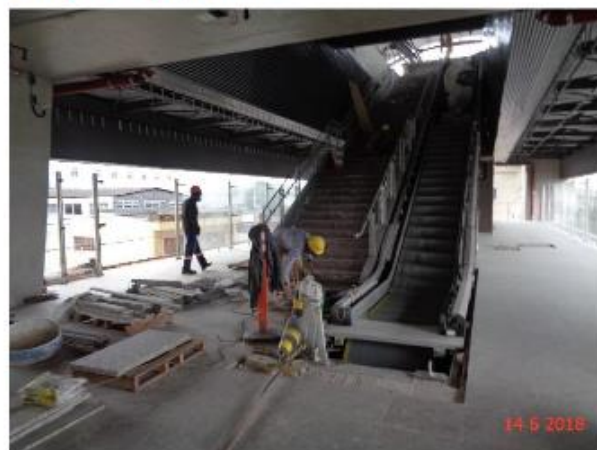
Execução do piso de granito da escada de acesso a Plataforma.
