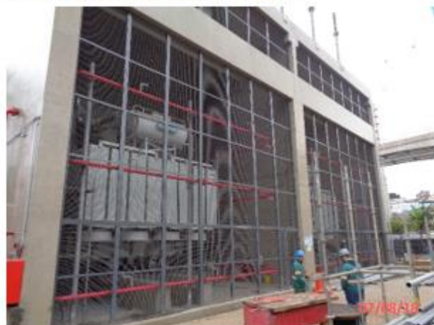
Montagem do sistema de combate a incêndio.
