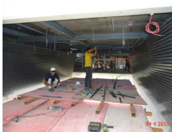
Instalação do forro do mezanino
