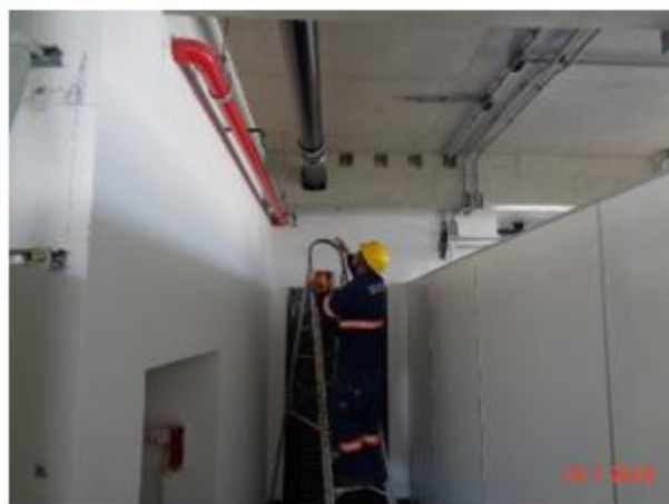
Pintura da tubulação de hidráulica
