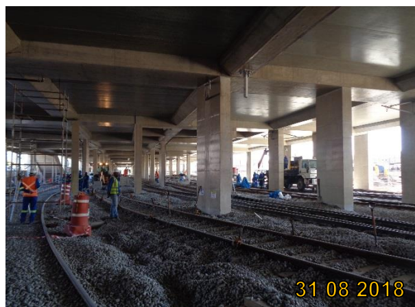
Nível Pátio (Terminal de Ônibus Vila Sônia): Vias Permanentes e AMVs (Feixe de entrada vias 1 a 5) em instalação.
