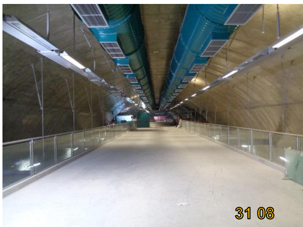
Corpo da Estação: Dutos de ventilação principal e luminárias em instalação.
