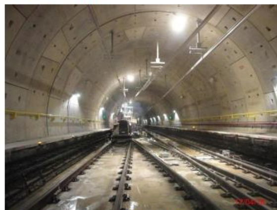
Trecho Moema – AACD-Servidor: Concluída via permanente
