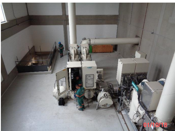
Cabos de comando da GIS em verificação para posterior teste a partir dos painéis de controle.
