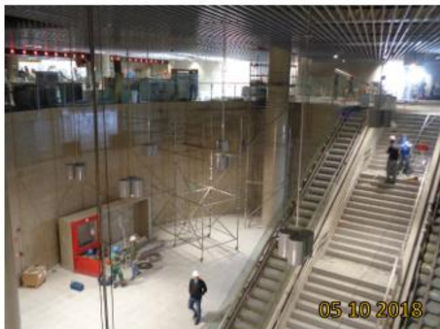
Acesso Norte: Escadas rolantes do Poço Principal em instalação. Bloqueios em fase de comissionamento. Acabamentos em execução.
