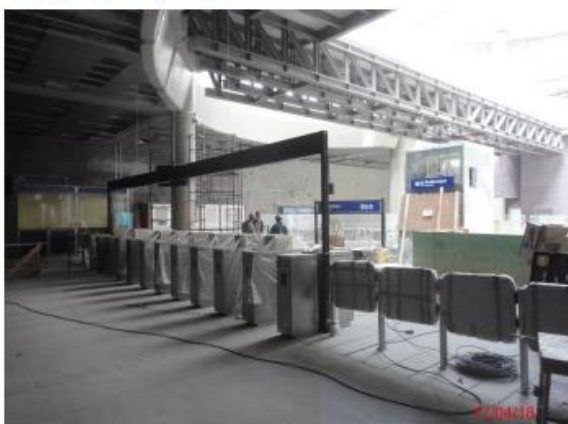
Acesso Sul: Instalação da linha de bloqueios
