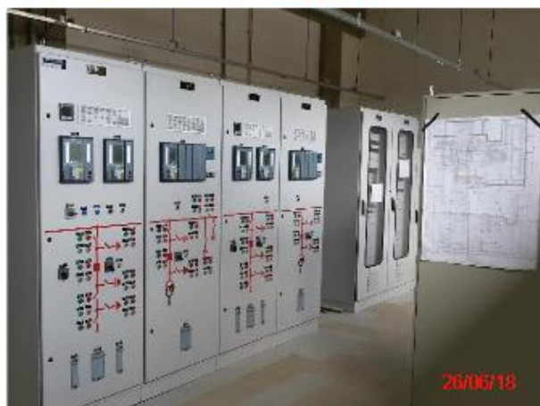
Montagem dos painéis de Alta Tensão.
