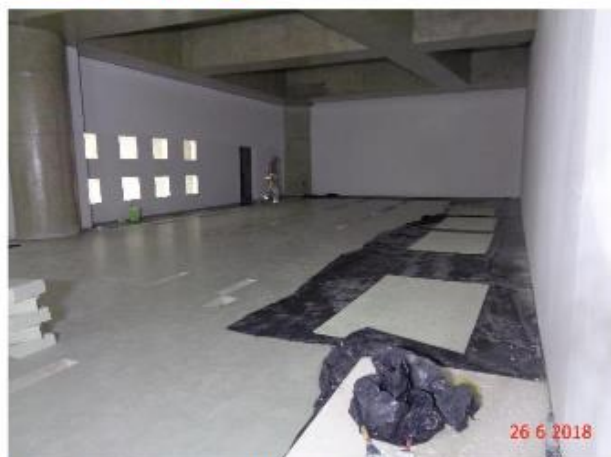
Salas Técnicas: Instalação do piso vinílico em execução
