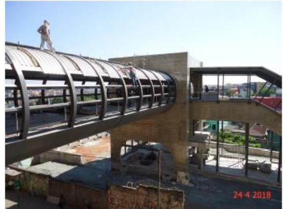
Instalação da segunda camada de telhas da passarela do Acesso Norte
