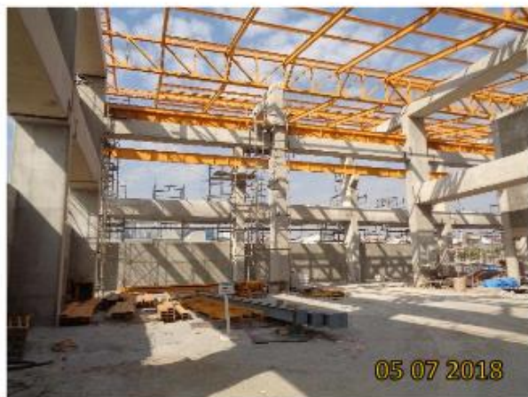
Bloco F: Cobertura Metálica em execução.
