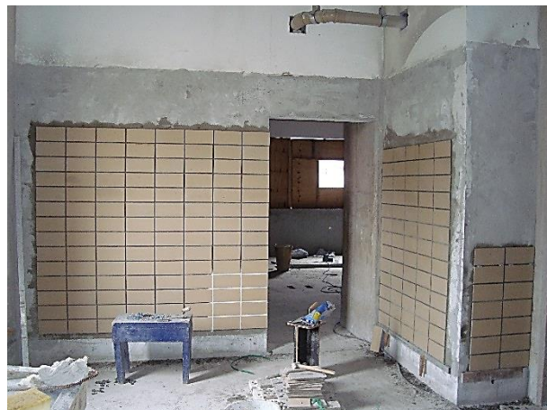
Execução do revestimento de azulejo
