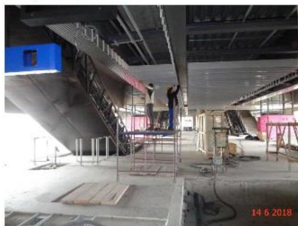
Instalação do forro do mezanino.
