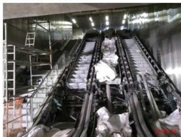
Mezanino Linha 5 - Lilás: Instalação de escadas rolantes de acesso à Linha 2 - Verde
