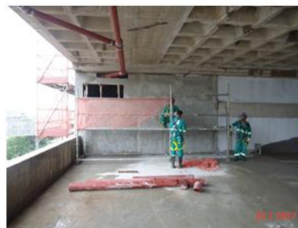
Bloco B: Execução da alvenaria, emboço, tratamento de concreto e instalações hidráulicas
