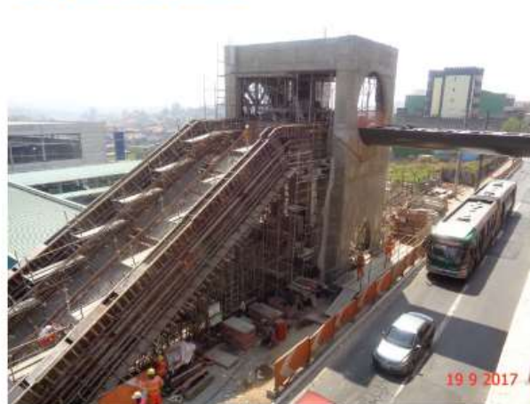
Execução da estrutura das caixas das escadas do Acesso
