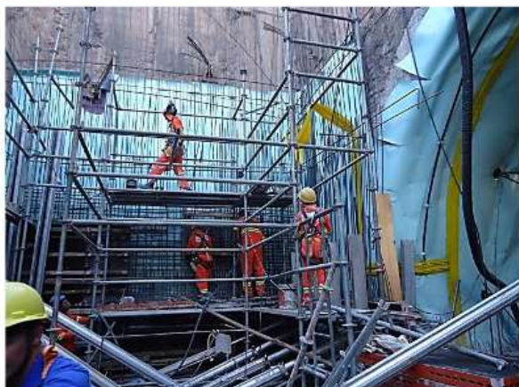
Execução do secundário do túnel de ligação ao Aeroporto.
