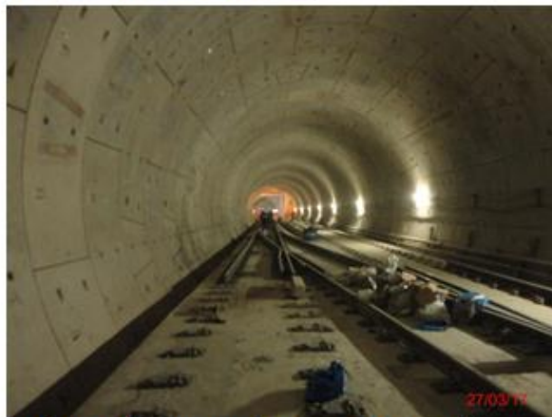
Trecho Estacionamento de trens – AACD-Servidor: Instalação dos trilhos
