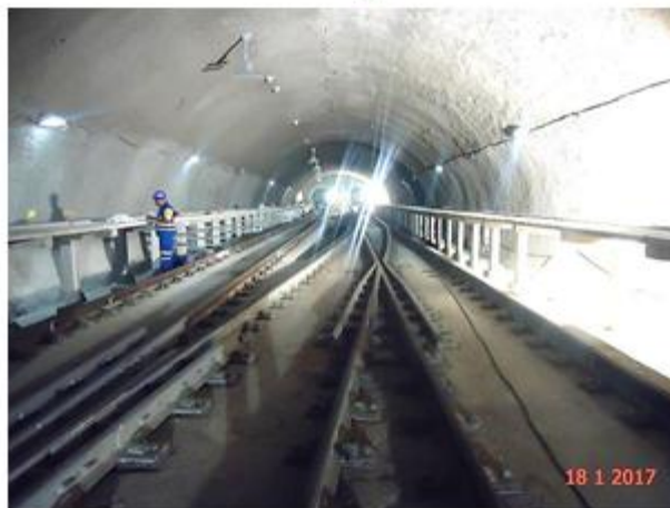
Instalação da passarela de emergência no trecho Brooklin – Campo Belo
