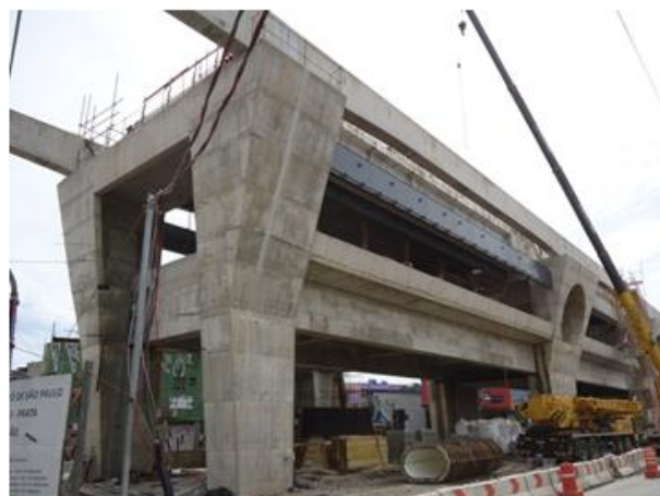
Lançamento das vigas metálicas do passadiço no Corpo da Estação.
