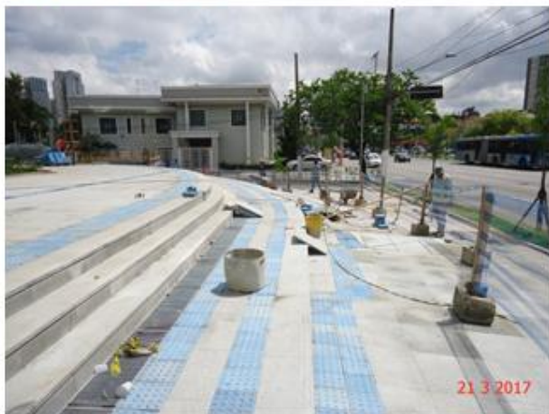
Acesso Principal: Assentamento do granito e piso tátil
