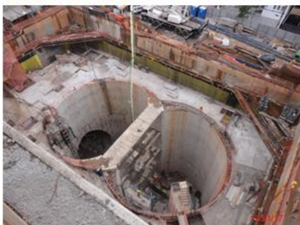
Revestimento secundário da Vala Otonis Sul
