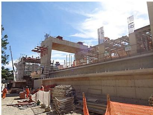
Execução de pilares principais da estação.
