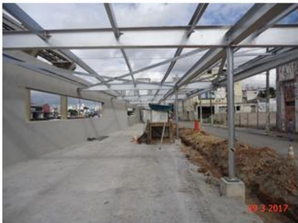
Execução do contra piso de concreto e instalação da cobertura metálica do Terminal Norte.
