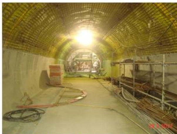
Acesso Adolfo Pinheiro: Execução do revestimento secundário do túnel
