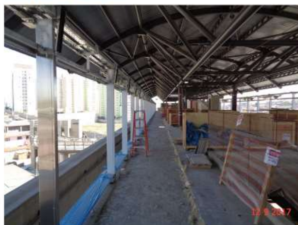
Montagem da estrutura das portas de plataforma.
