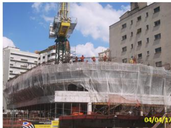
Acesso Jardins – Edificações das Salas Técnicas e Operacionais: Em execução formas e armações das paredes e da laje do nível Salas Operacionais.
