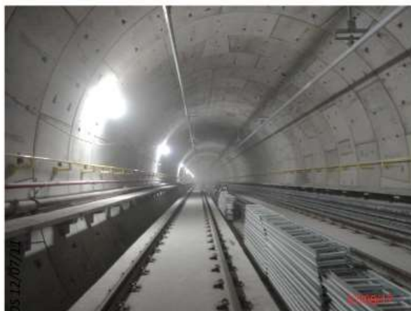
Trecho Eucaliptos – Moema: Instalação do bandejamento
