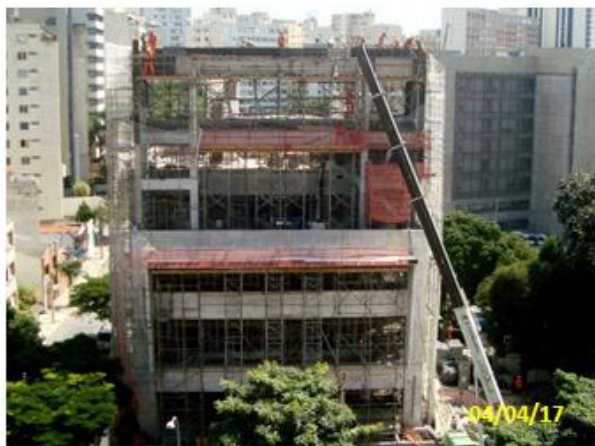
Acesso Mackenzie – Edificações das Salas Operacionais: Em execução estruturas de concreto dos pilares dos canais de exaustão e do reservatório.
