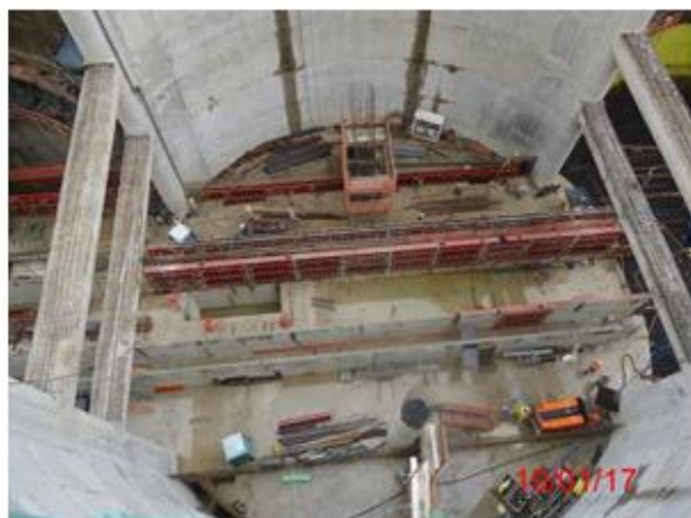
Corpo da estação: Execução do porão de cabos do Poço 4
