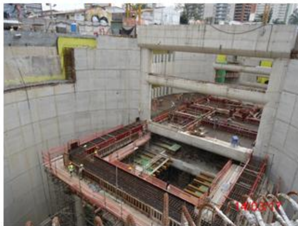
Corpo da estação: Execução do mezanino superior – Poços 1 e 2
