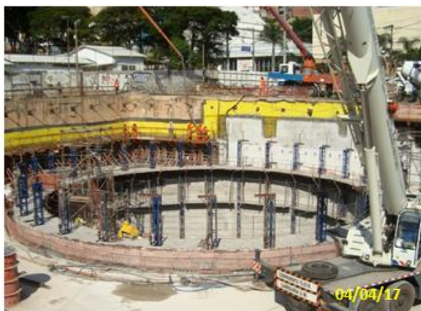
Acesso Norte: Impermeabilização e revestimento secundário do VCA em execução. Revestimento Secundário em conclusão.
