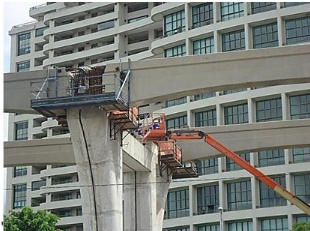
Vias (Contrato CMI) – lançamento de viga-guia.
