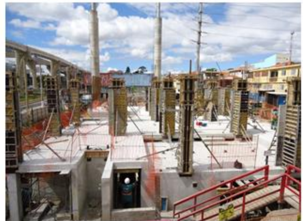
Execução das paredes das salas técnicas.
