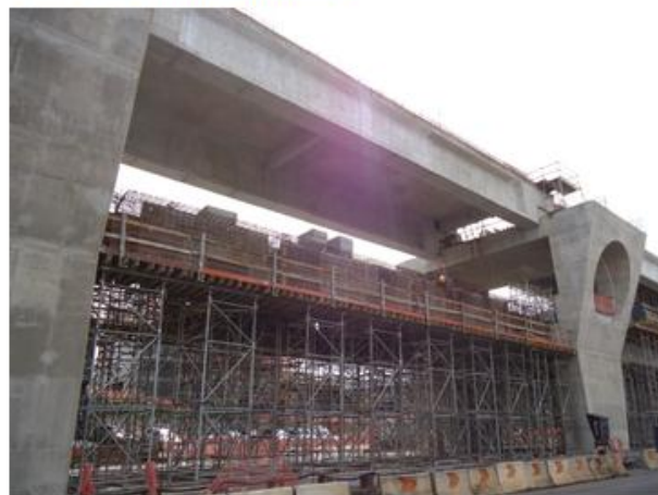
Execução do mezanino e plataforma do Corpo da Estação.
