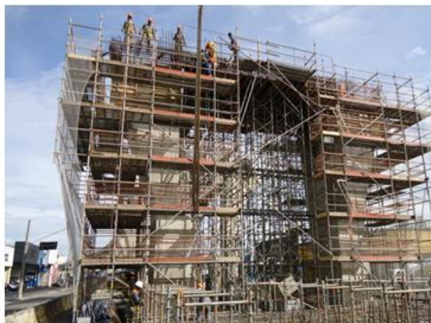
Execução dos pilares do Corpo da Estação.
