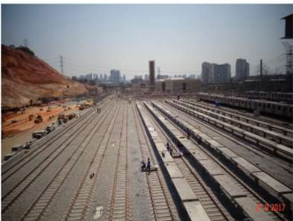
Via Permanente Fase II: Dormente, trilhos e passarelas de serviço.
