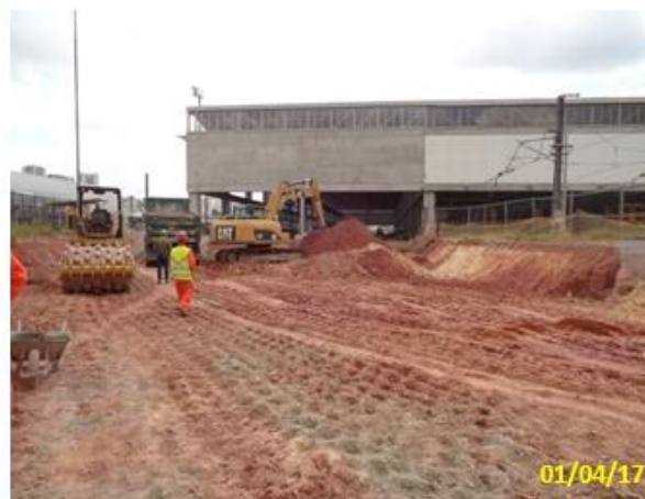
Bloco A – Feixe de Entrada: remanejamento de interferências e preparação para implantação das vias permanentes em execução
