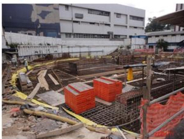
Armação da laje de cobertura
