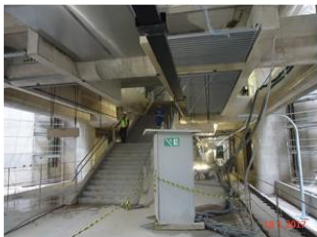
Plataforma: Instalação do forro, suporte da luminotécnica e comunicação visual
