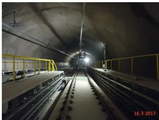
Trecho Adolfo Pinheiro – Alto da Boa Vista: Instalação de guarda corpo na passarela de emergência
