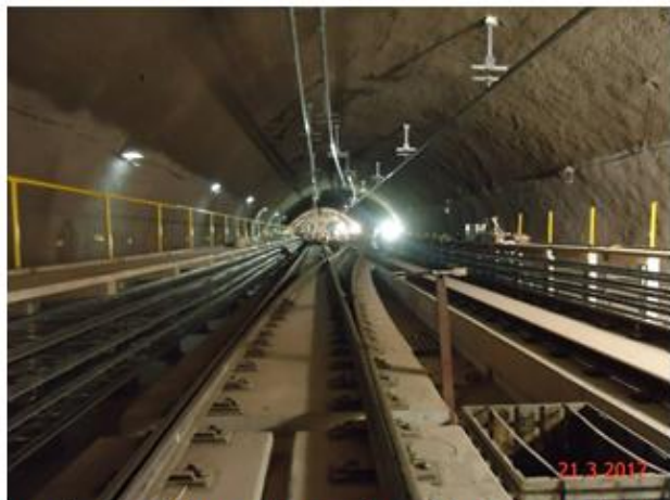
Trecho Brooklin – Campo Belo: Solda de Aparelhos de Mudança de Vias - AMV's e instalação do corrimão e guarda corpo na passarela de emergência
