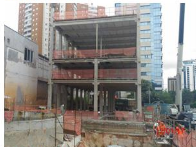
Salas técnicas: Montagem da estrutura pré-moldada
