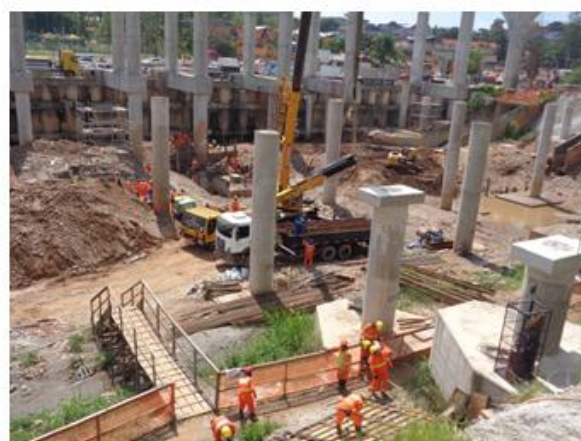
Pátio Água Espreada – Execução de blocos e pilares.
