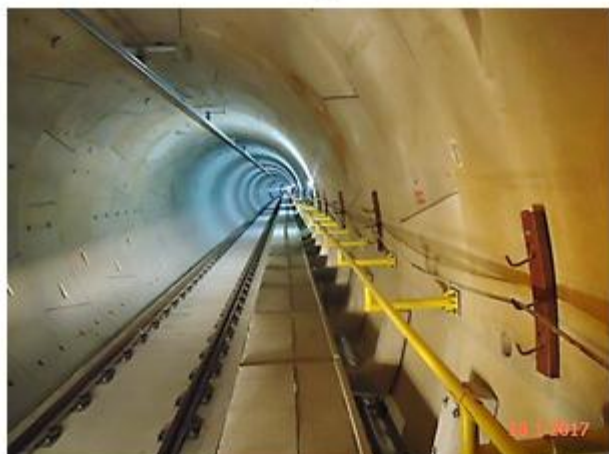
Instalação do corrimão trecho Brooklin – Borba Gato
