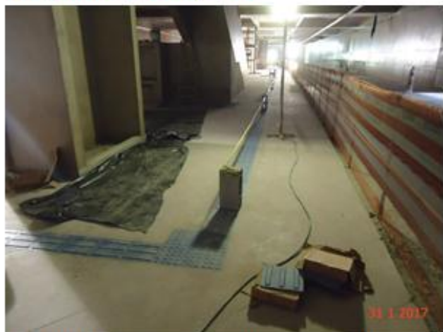
Plataforma: Assentamento do porcelanato e piso direcional
