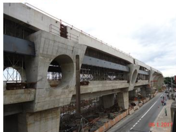
Execução da laje da plataforma e lançamento das vigas guia.
