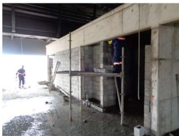
Execução da alvenaria das Salas Operacionais no Mezanino.
