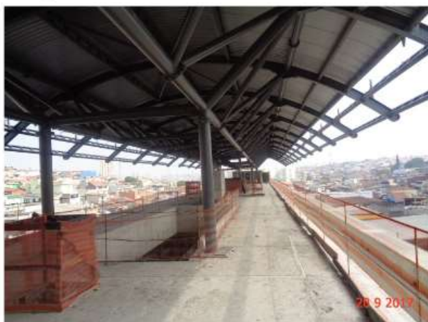
Instalação da primeira camada da telha metálica da cobertura.
