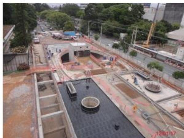
Término da impermeabilização da laje de cobertura
