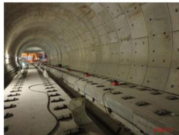
Macaqueamento da laje do sistema massa-mola no trecho Estacionamento de trens - AACD-Servidor
